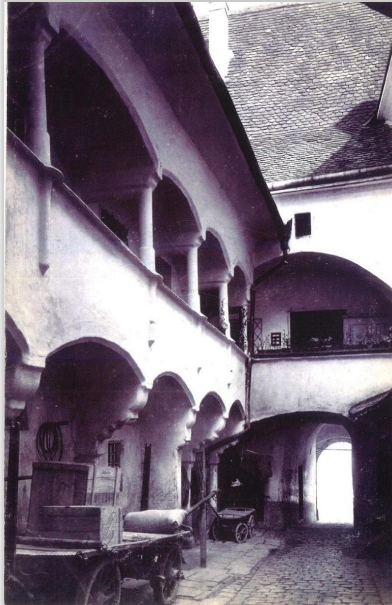
Abbildung 38: Innenhof von Stadtplatz Nr. 11 mit Zugang zum Ennskai ca. 1912 (StA Steyr, Fotosammlung der Freunde der Geschichte der Stadt Steyr und der Eisenwurzen).
