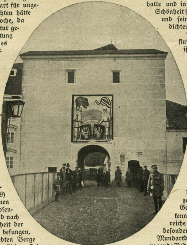
Das alte Ennstor in Steyr.
