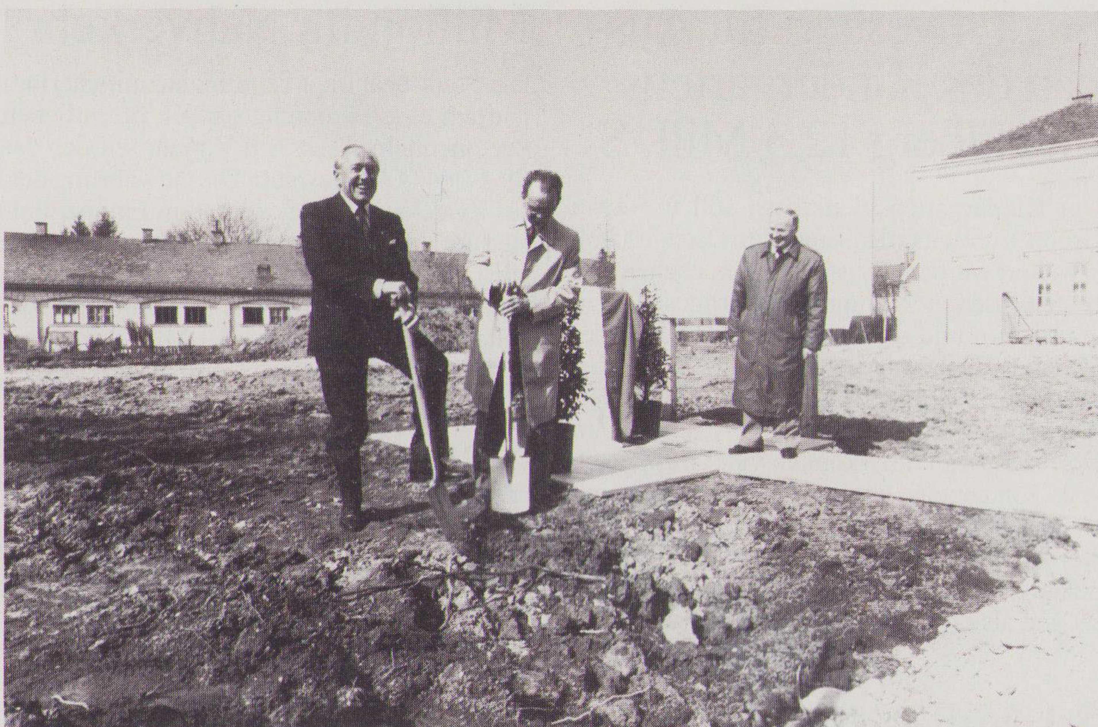
Landesrat Leo Habringer und Bürgermeister Heinrich Schwarz beim Spatenstich.
