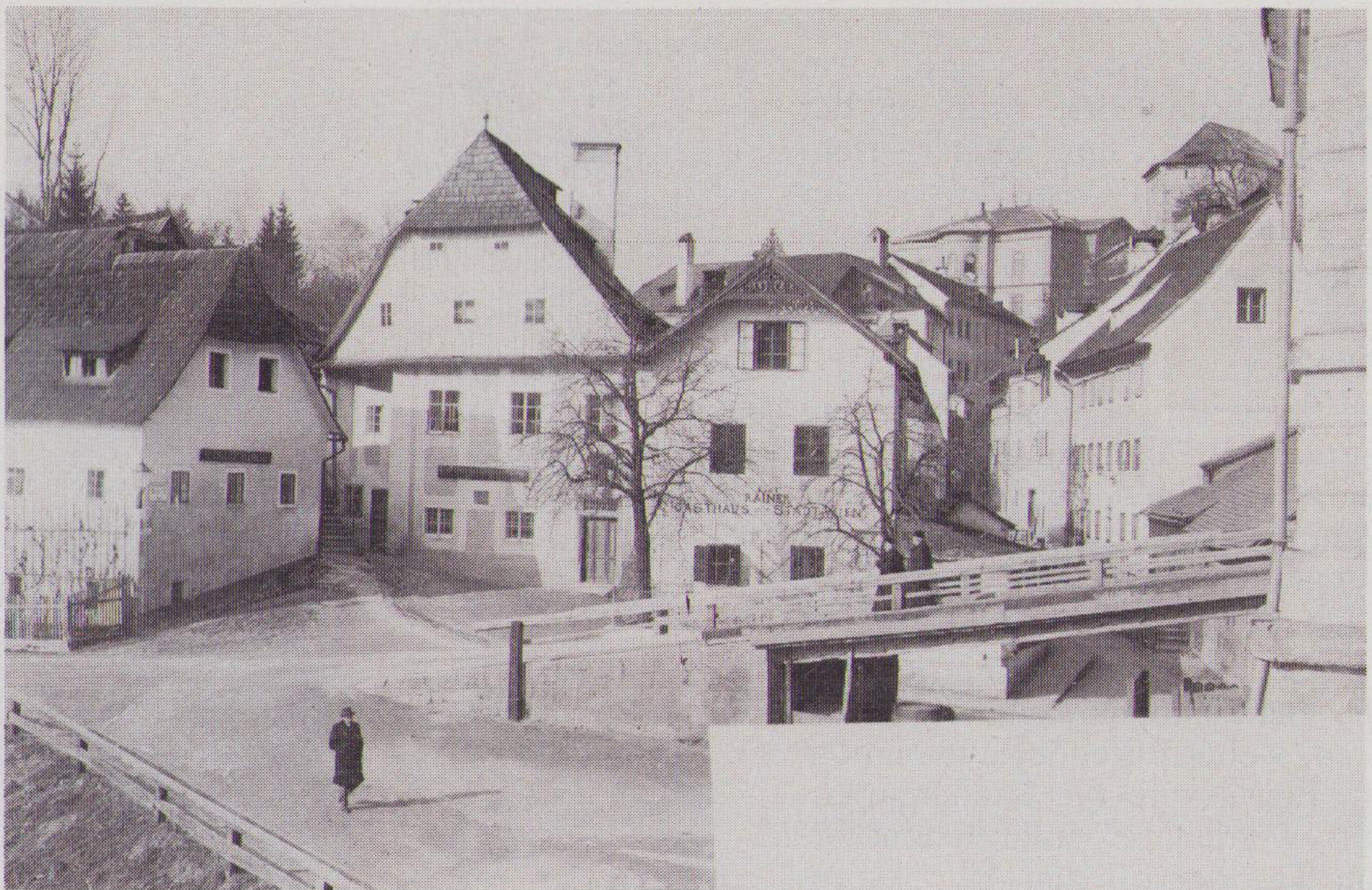
Ensemble südlich des Neutores vor dem Bau der Schönauberbrücke. Foto: Heimathaus.
