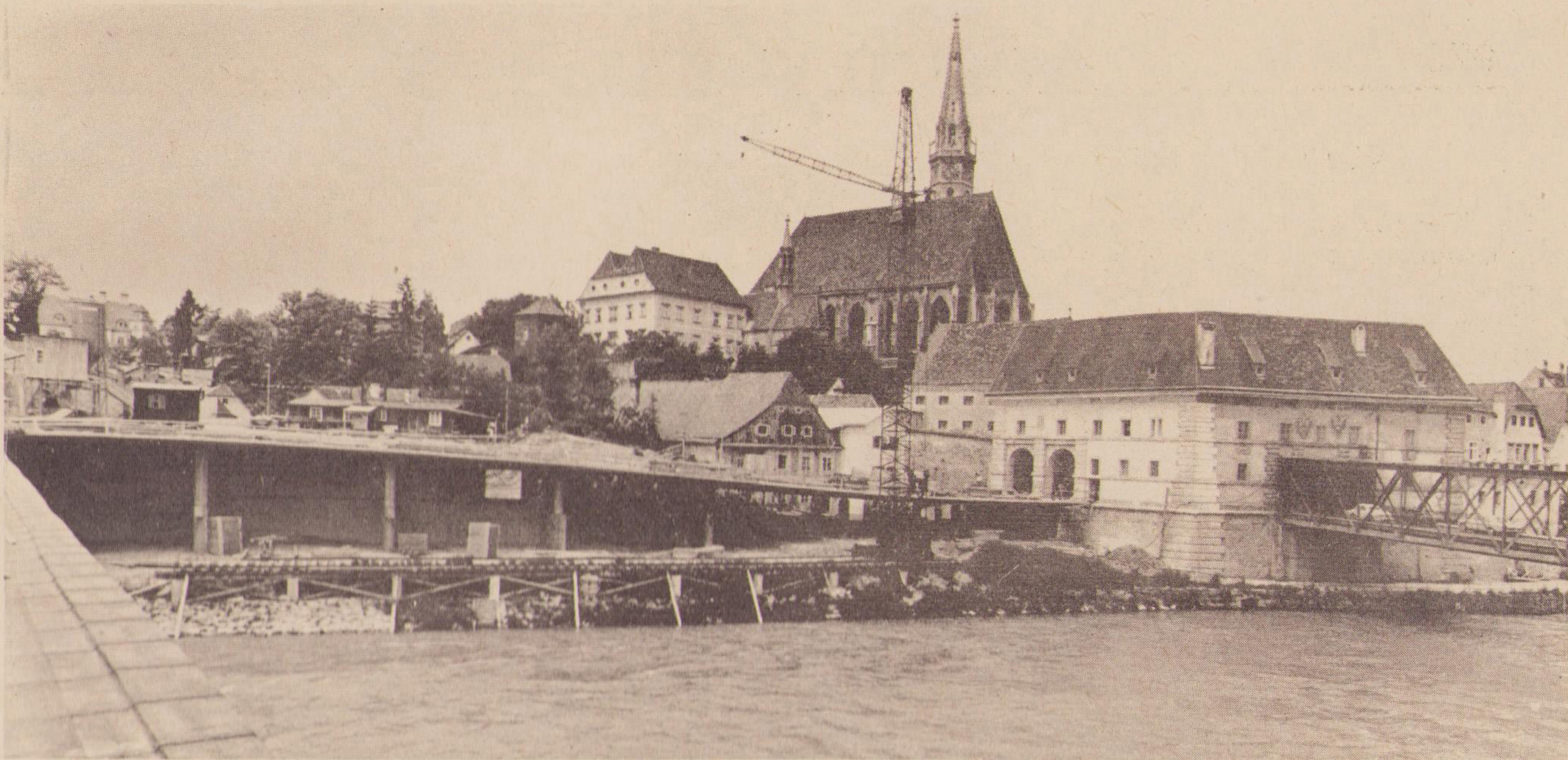
VOR EINIGEN WOCHEN WURDE DIE VORLANDBRÜCKE DER IM BAU BEFINDLICHEN SCHÖNAUERBRÜCKE AN DA NEUTOR ANGESCHLOSSEN. DAMIT WURDE WIEDER EIN WESENTLICHER BAUABSCHNITT TERMINGERECH ABGESCHLOSSEN. DAS BILD ZEIGT DIE VORLANDBRÜCKE VON DER NEUEN BRÜCKE AUS GESEHEN.
