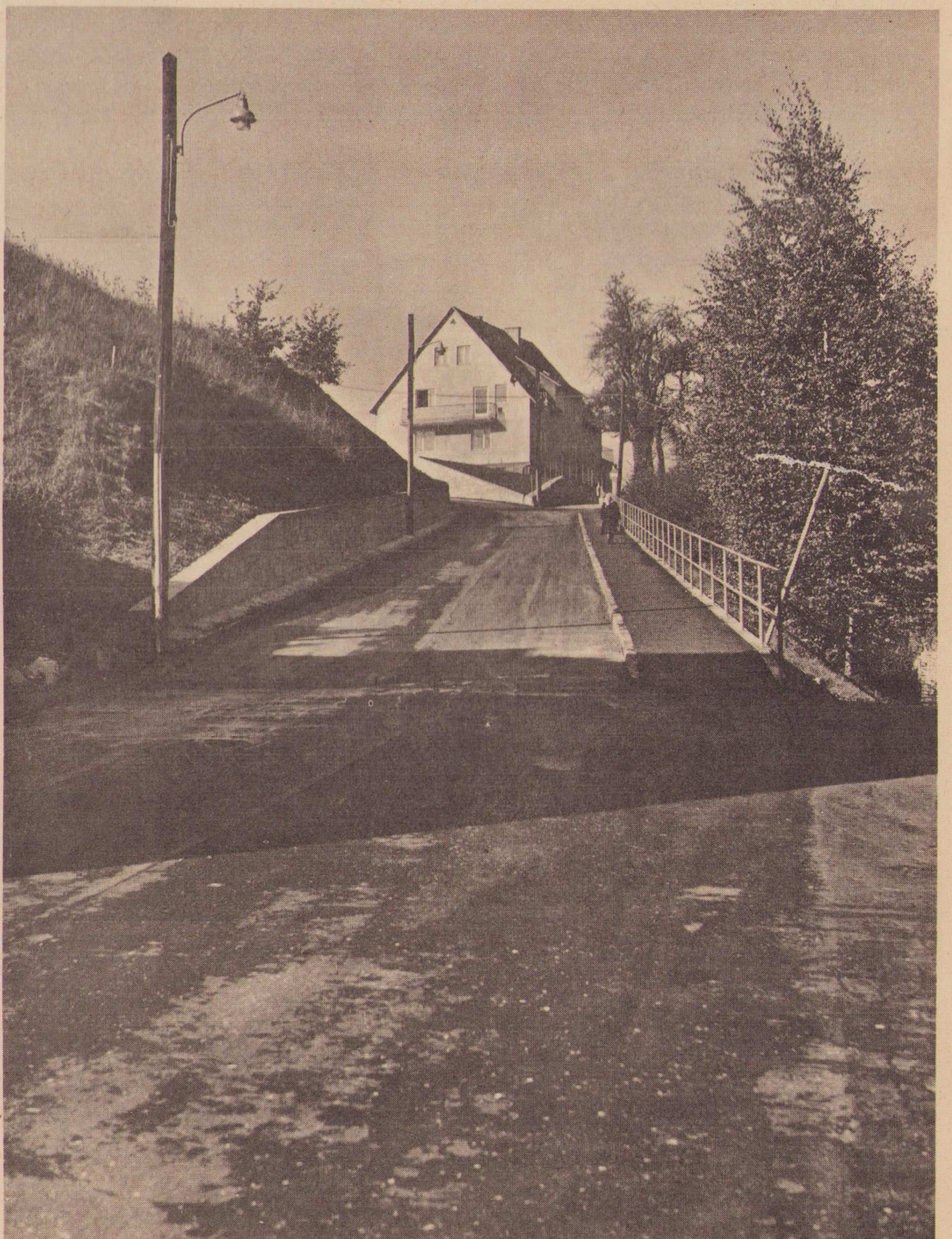
DIE NEUE STRASSE NACH BEENDIGUNG DER BAUARBEITEN
