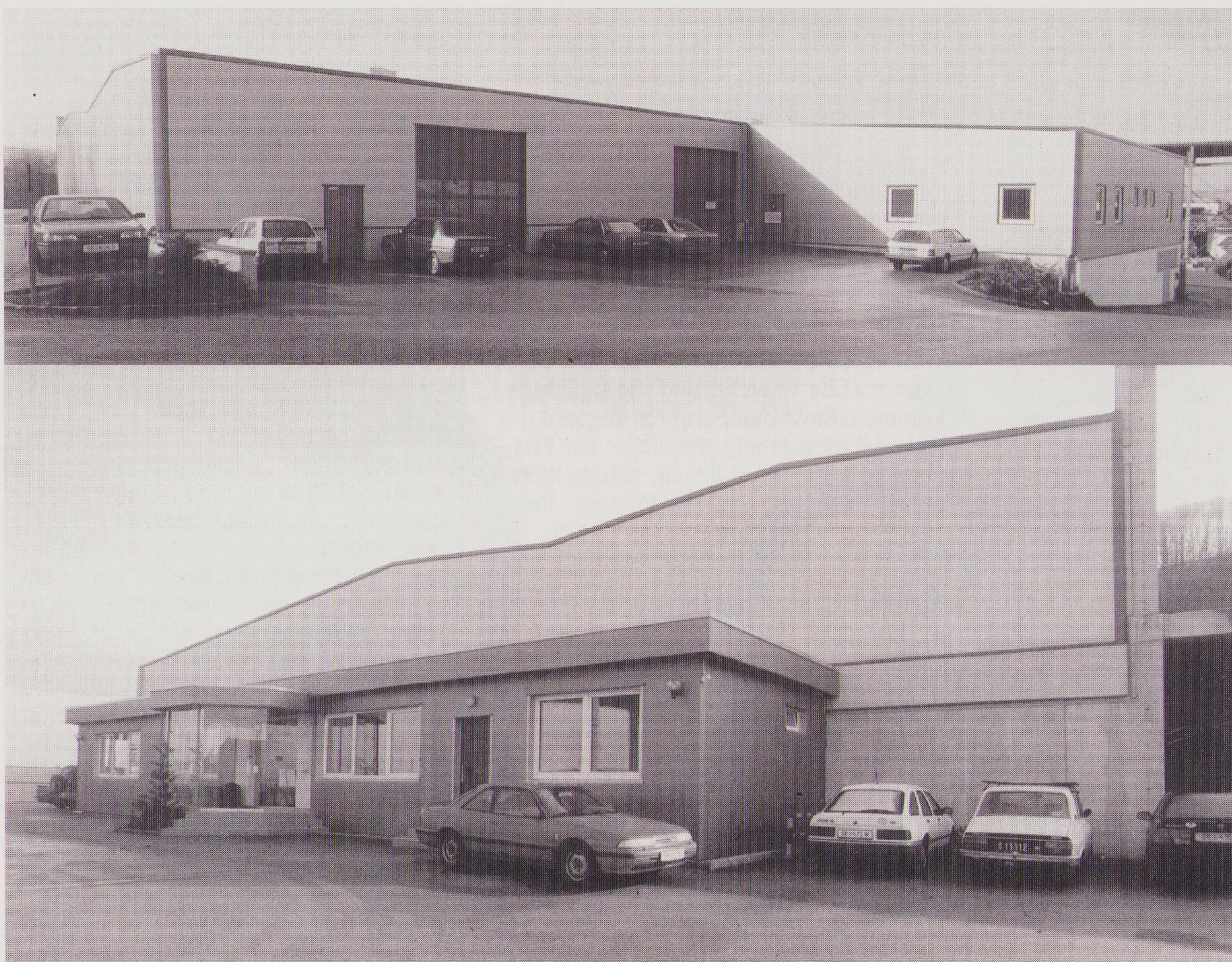
Zwei Lagerhallen (oben) und Bürogebäude wurden aus dem Besitz der Firma Gebeshuber gekauft und werden für die Bedürfnisse der „Geschützten Werkstätte“ eingerichtet.
