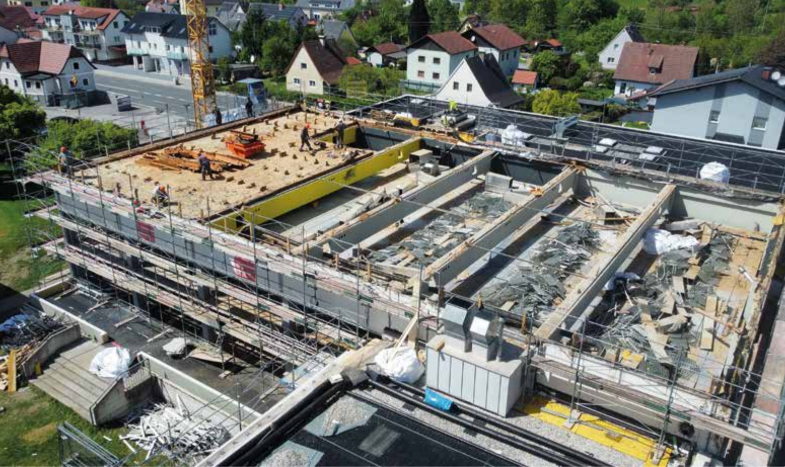
▲ Abbruch des Hallendaches
