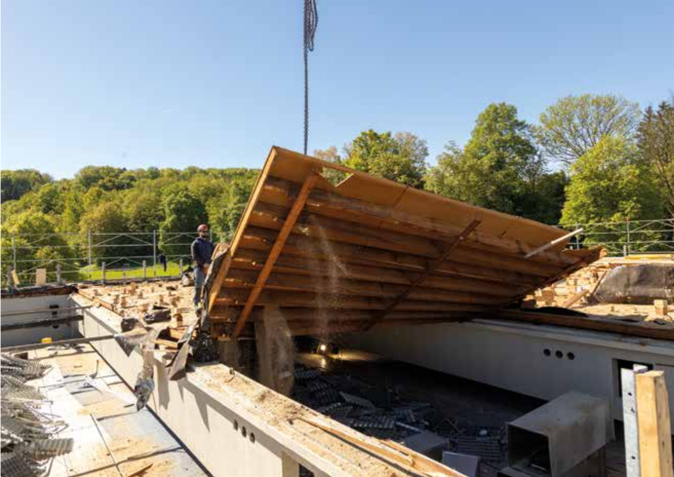
Plateau-Gerüst in der Schwimmhalle
