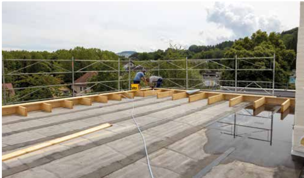
Hallendach mit Notabdichtung (Dampfsperre) und Unterkonstruktion der Traufenausbildung ▼
