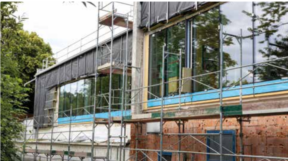
Die neue Pfosten-Riegel-Fassade und die Dämmebene der neuen hinterlüfteten Fassade (an der Seite zum Ramingbach)
