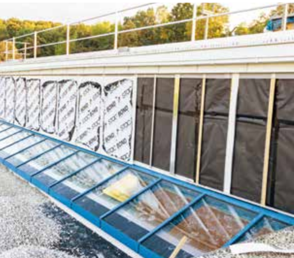
dem Sauna-Abgang. Darüber sind die Deckplatten der Fassade zu sehen.
