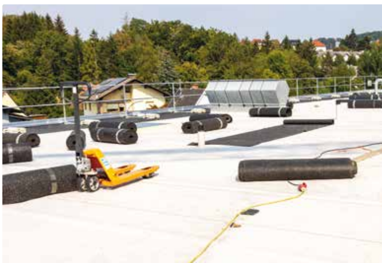
Auf dem Flachdach über dem Garderobentrakt werden die Gummi- granulatmatten ausgerollt – zum Schutz der Dachhaut. An der Dach- kante wurde ein Geländer montiert (Kollektivschutz), damit Wartungs- arbeiten auf dem Dach sicher ausgeführt werden können.
