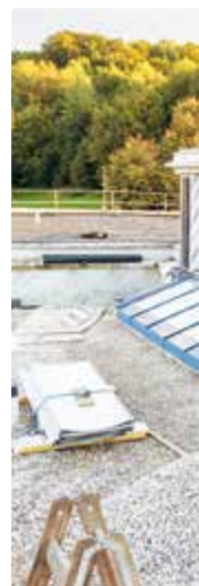
Schrägverglasung über hinterlüfteten Hallenfas
