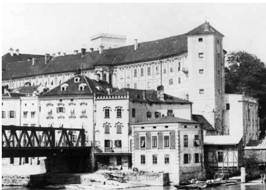
Die Gebäude Zwischenbrücken Nr. 1 (heute Studienbibliothek) und Nr. 2 (Fischergschirr) können am 29. September bei einer Führung besichtigt werden.
