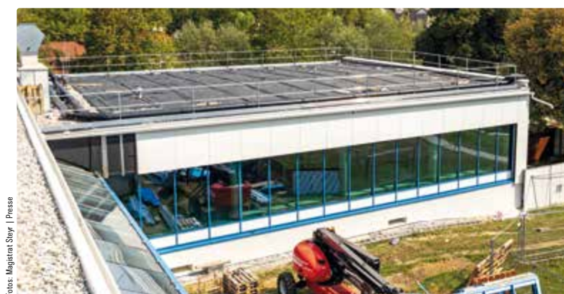
Die Lehrschwimmhalle ist mit einer Pfosten-Riegel-Fassade ausgestattet worden.
