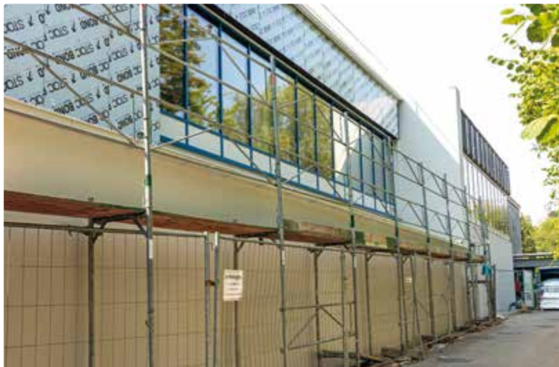
Die thermisch sanierte Fassade an der Seite zum Ramingbach (Eingangsbereich Freibad)
