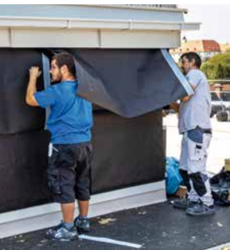
hinterlüfteten Fassade wird montiert.
