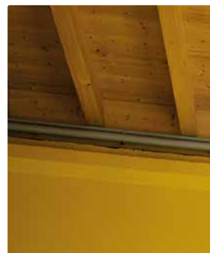
Durch die neu errichtete Holzdecke und die warme Farbge
