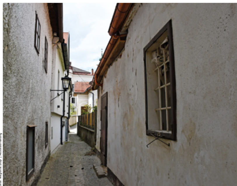
Das Haus Fischergasse 3 vor und nach der Gesamtanierung
