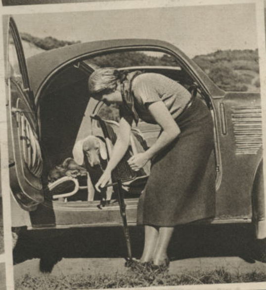
Der Steyr-Vigot-Wagenheber erlaubt leichten Räderwechsel
