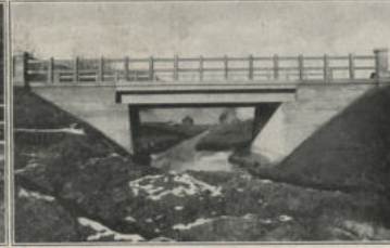
Bundesstraßenbrücke über den Zeller-See bei Zell a.S., ausgeführt im Auftrage der Landesregierung Salzburg
