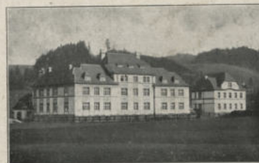
Ausführung von zirka 2000.— m 2 Eisenbetondecken „System Visintini“ für den Neubau des Krankenhauses in Waidhofen an der Ybbs
