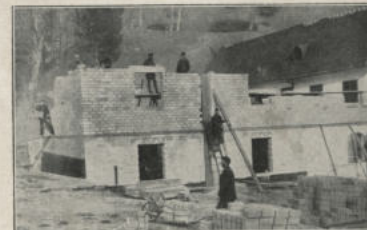
Betonhohlsteinbau (Fabriksgebäude mit darüber befindlichem Sensen-Magazin), ausgeführt für die Firma: Ludwig Zeitlinger, Sensenwerke in Leonstein
