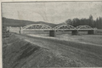
„Stöckler-Brücke“ über den Erlauffluß bei Pöchlarn, ausgeführt im Auftrage des Landes Niederösterreich
