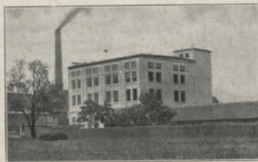
Brutfabrik und Kunstmühle der Firma: Josef Reder's Söhne, Garsten
