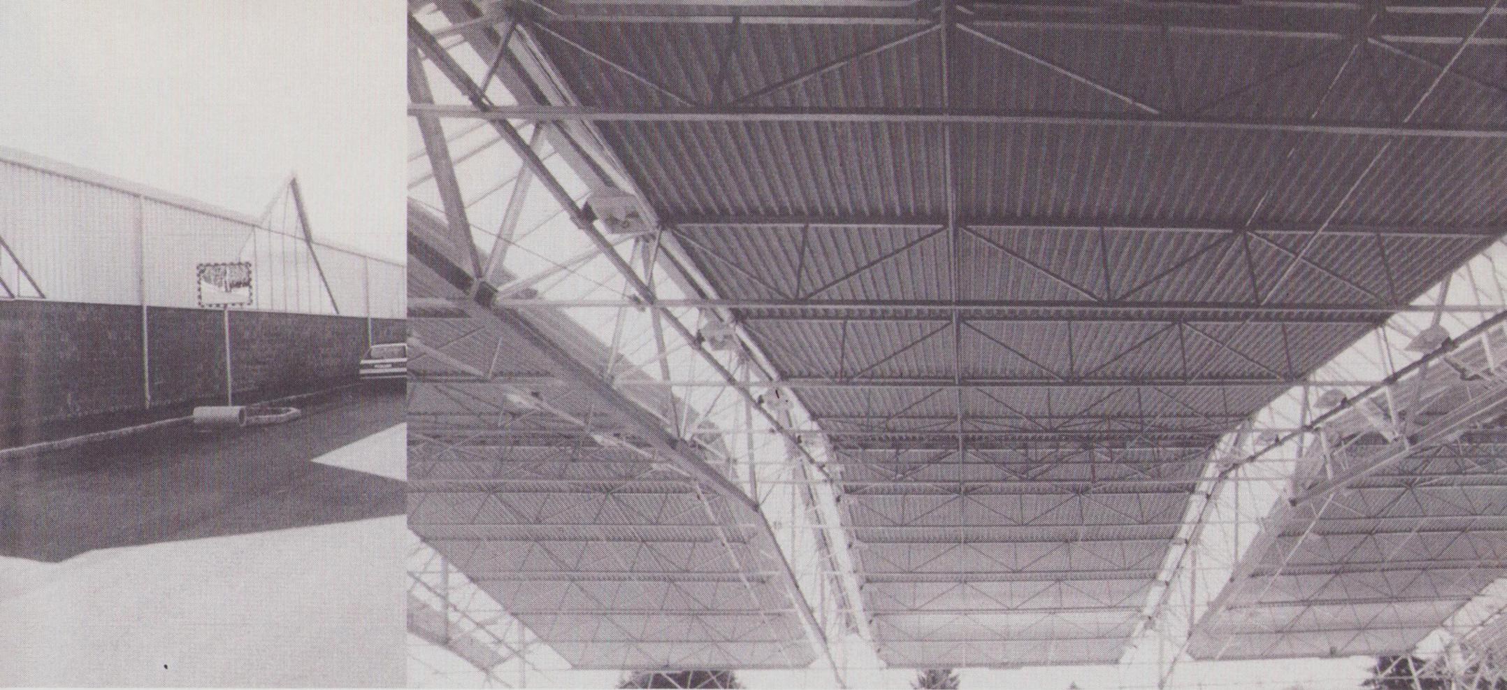
er überdachten Kunsteisbahn am Rennbahnweg    Mittelteil der Stahlfachwerkskonstruktion über der Kunsteisbahn mit einer Spannweite von 47 Metern.
