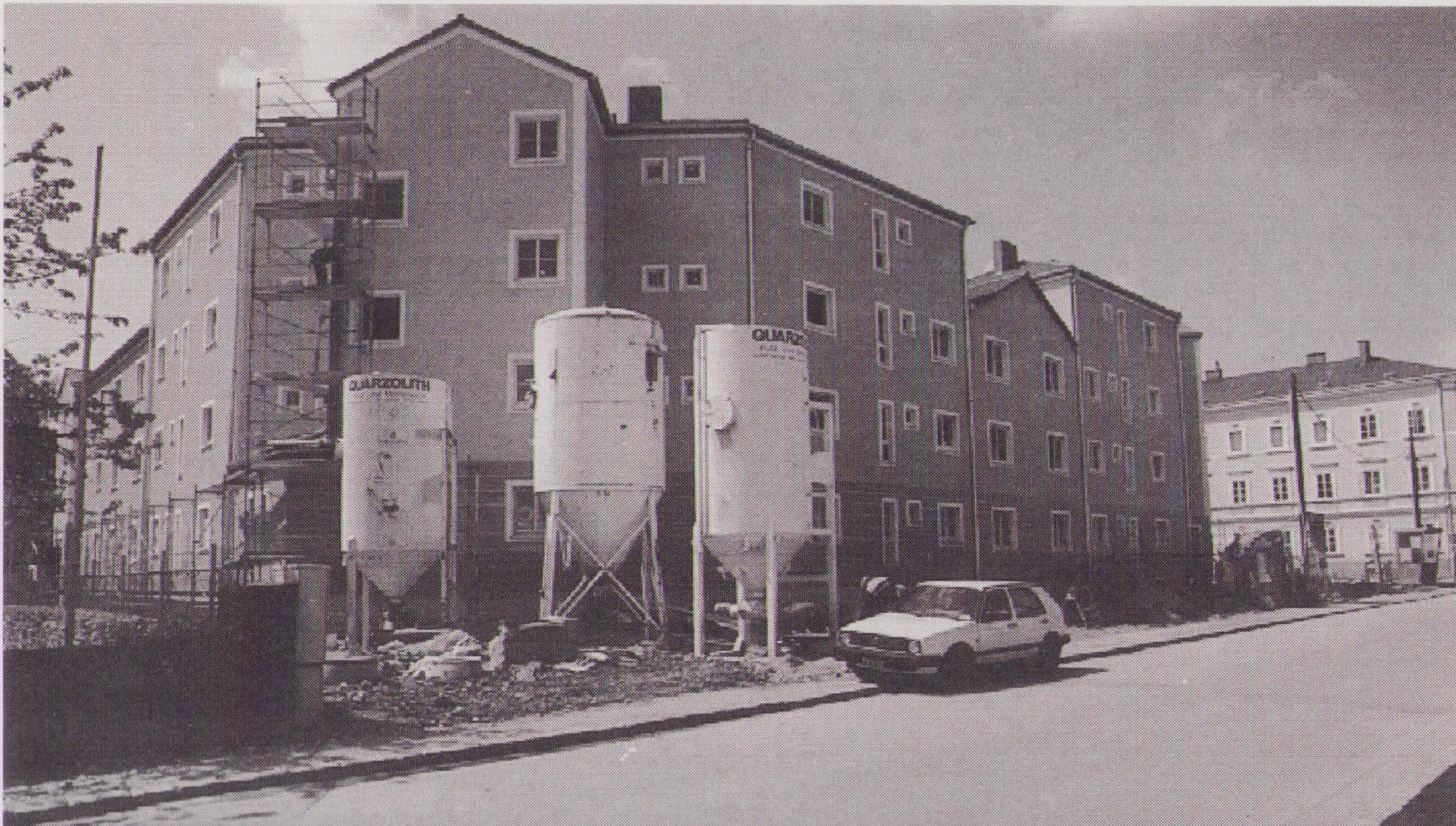
Im Wehrgraben sind 38 neue Wohnungen der Wohnungsgesellschaft der Steyr-Daimler-Puch AG bald beziehbar. Fotos: Hartlauer
