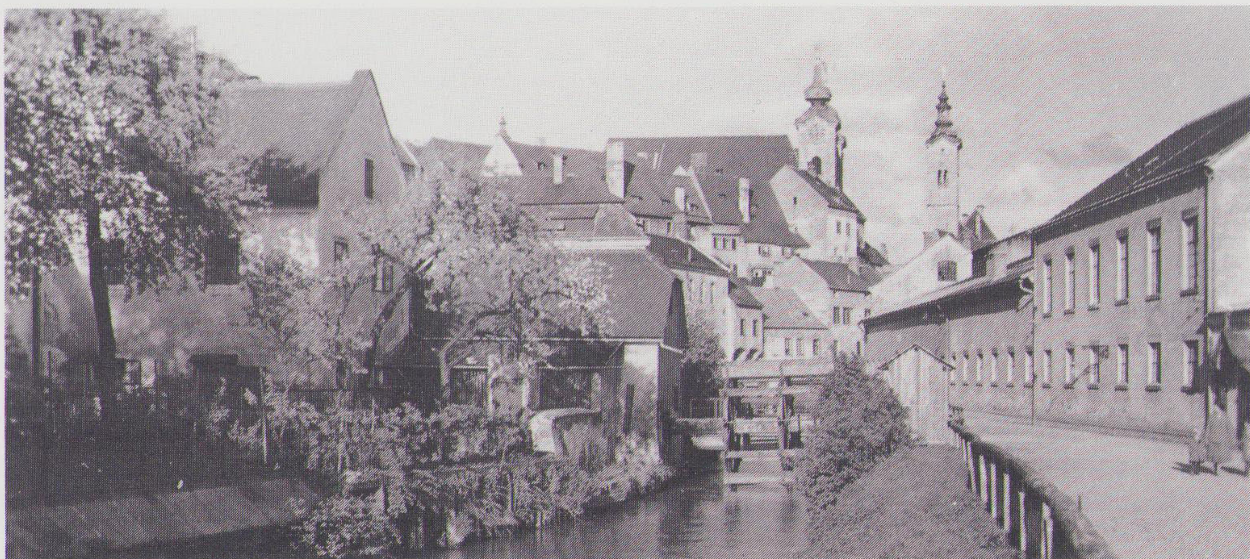
Wasserrad im Wehrgrabenkanal. Foto: Mörtl
