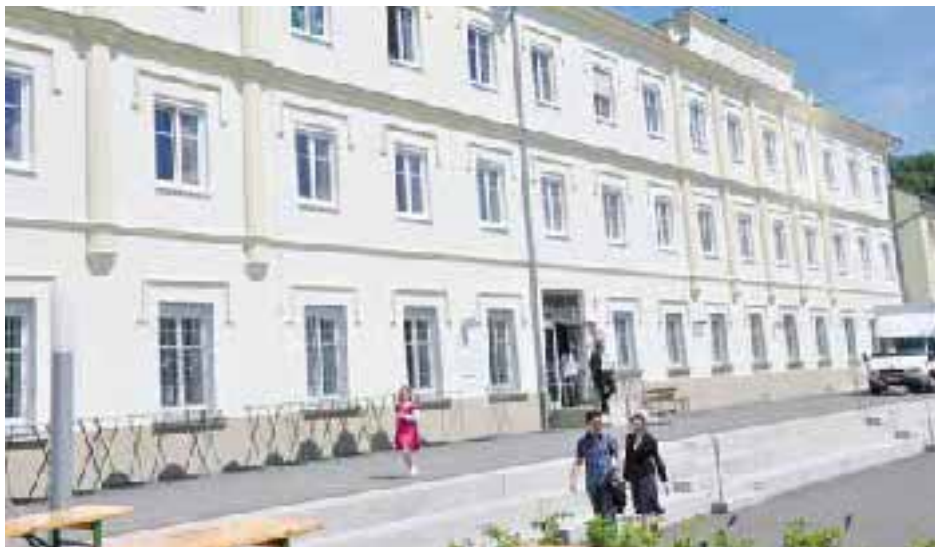
Die Volks- und Hauptschule sowie der Hort St. Anna zeigen sich nach der Generalsanierung im neuen Kleid.
