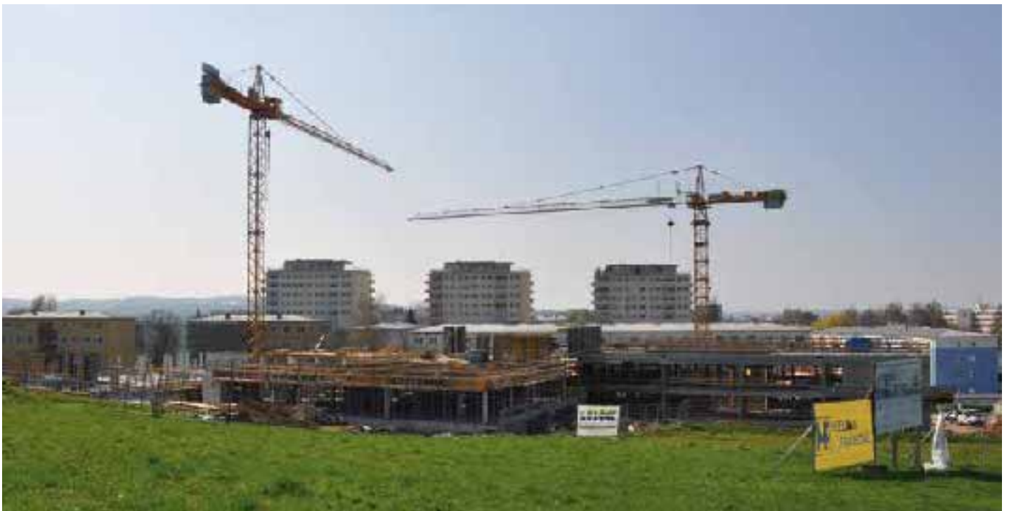
Eines der großen Projekte, die derzeit in Steyr umgesetzt werden, ist der Neubau des Alten- und Pflegeheims auf der Ennsleite. Eröffnet werden soll es im Sommer 2011.
