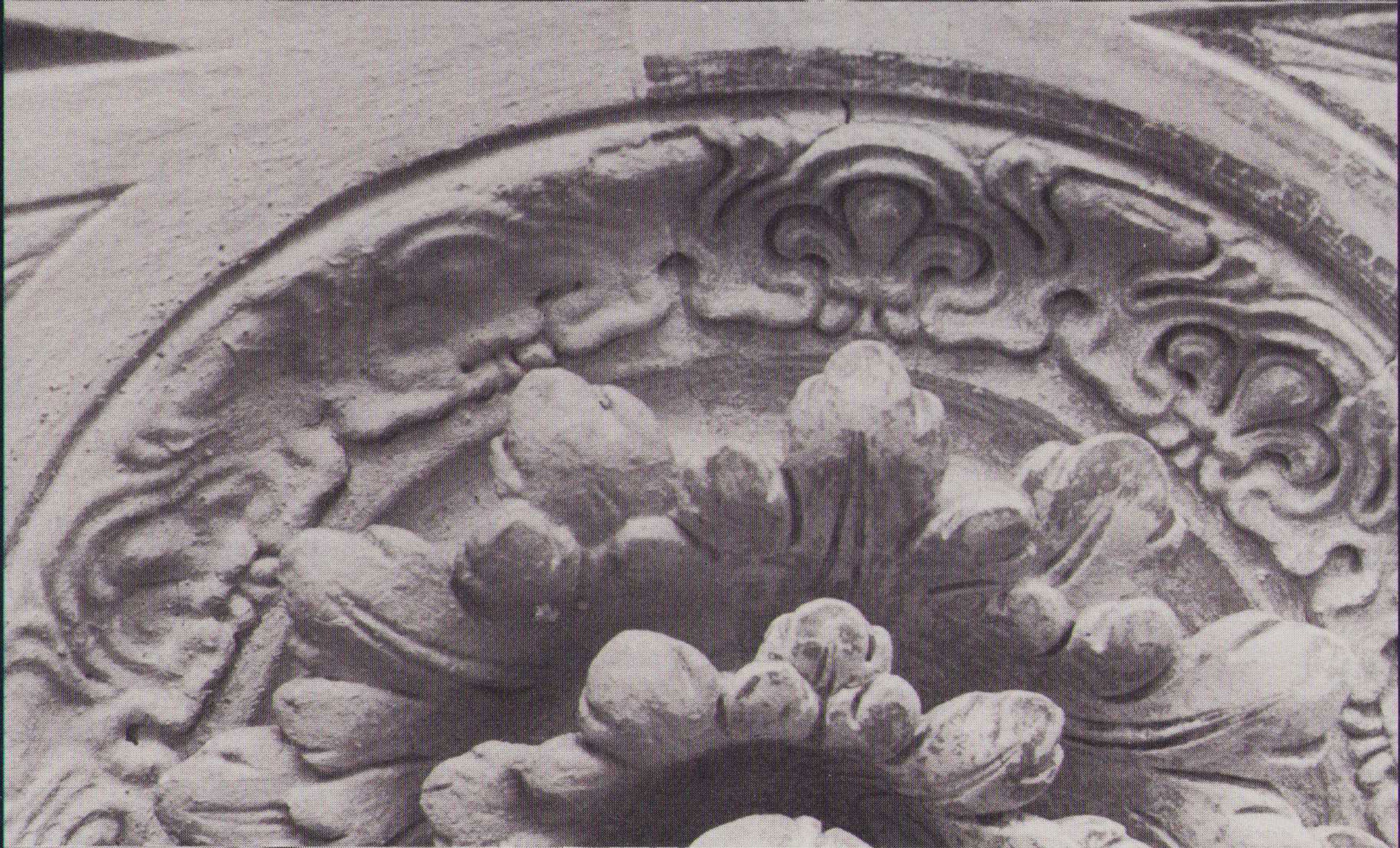
Nach Entfernung der Übermalungen hat der Stuck wieder die ur- sprüngliche Farb- igkeit und Detail- schärfe.
