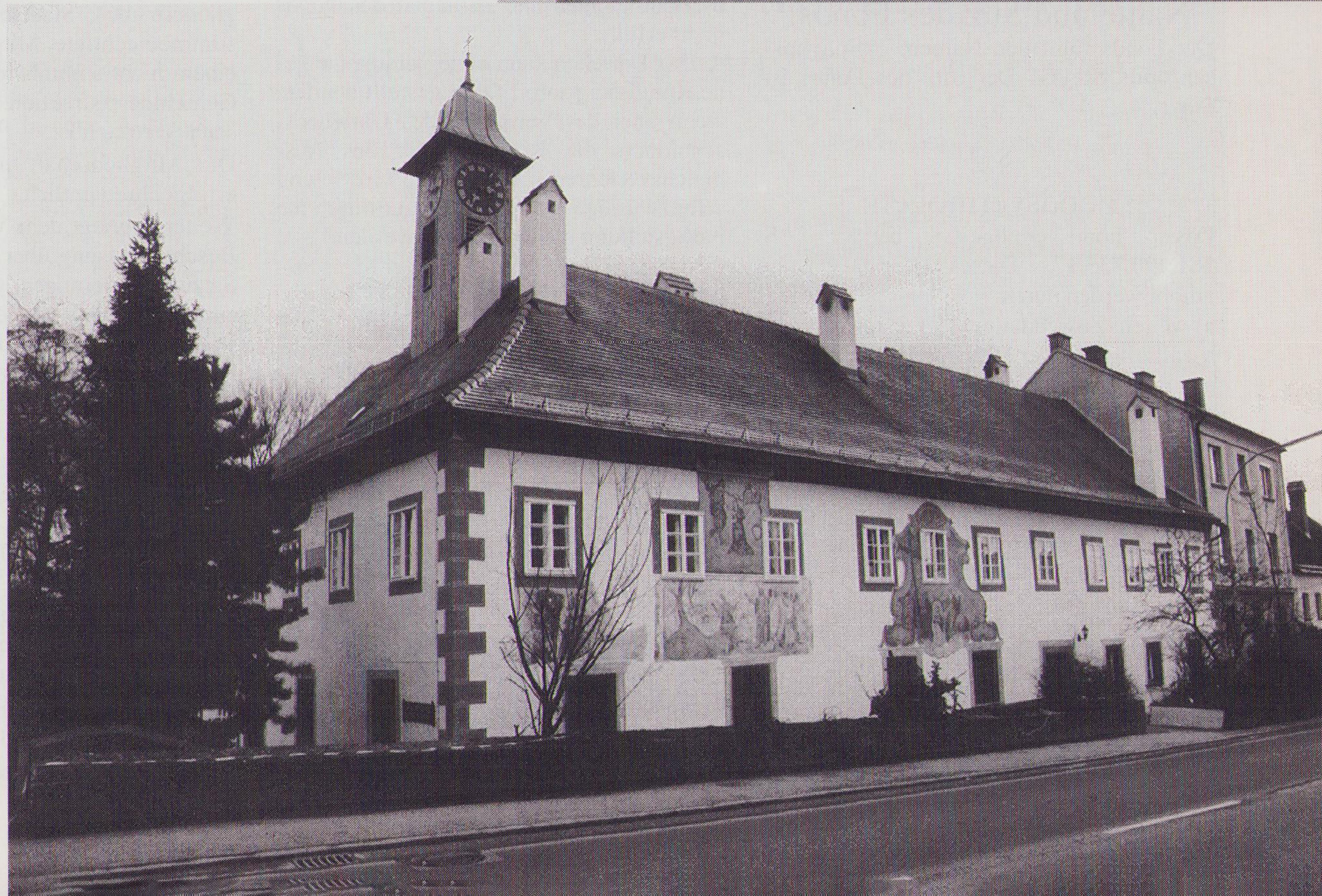
Rechts im Bild das restaurierte „Herrenhaus”. Fotos: Hartlauer
