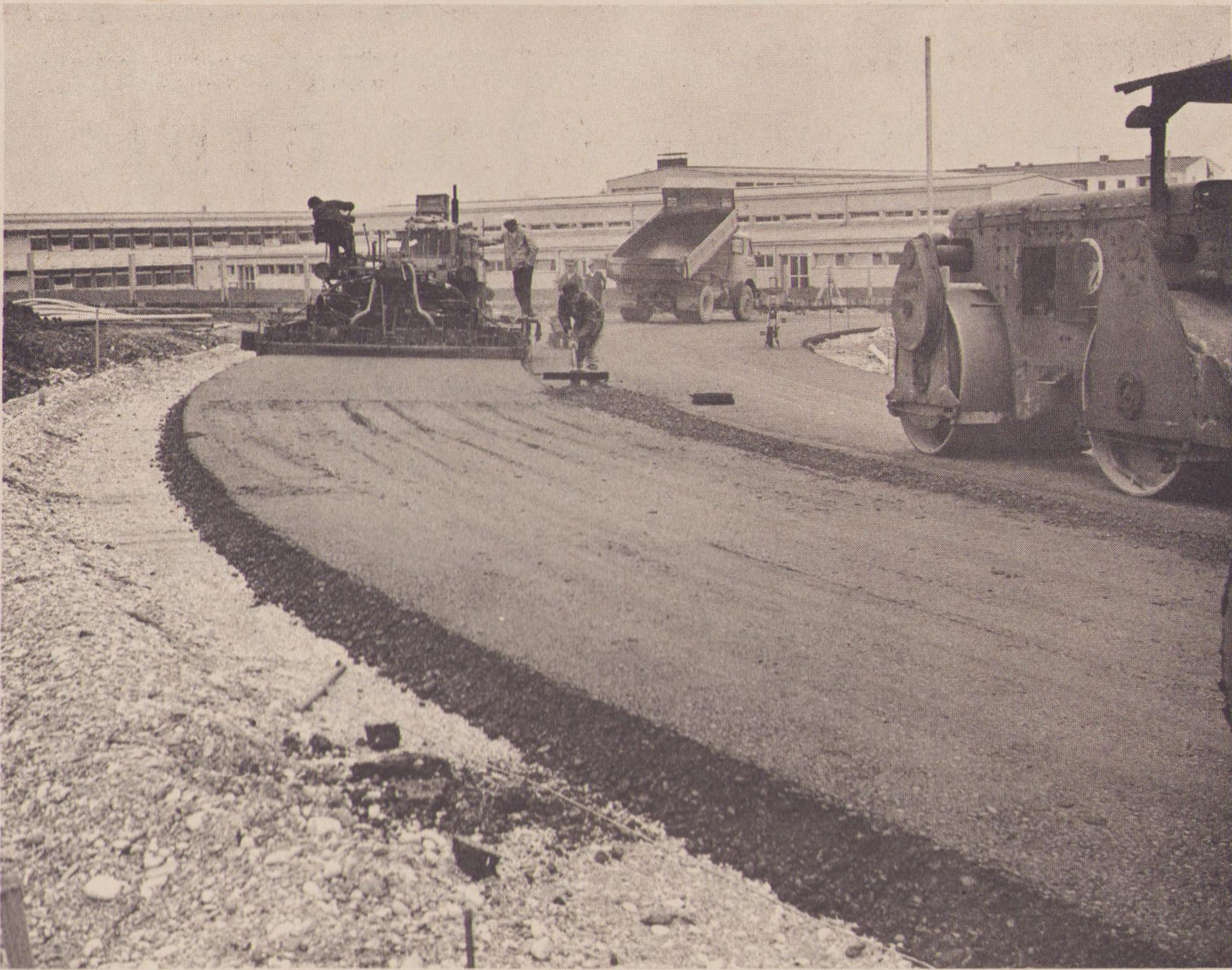
Auf dem Teilstück zwischen der Taborschule und dem zukünftigen Knoten Wolfernstraße sind derzeit die Asphaltierungsarbeiten in vollem Gange.
