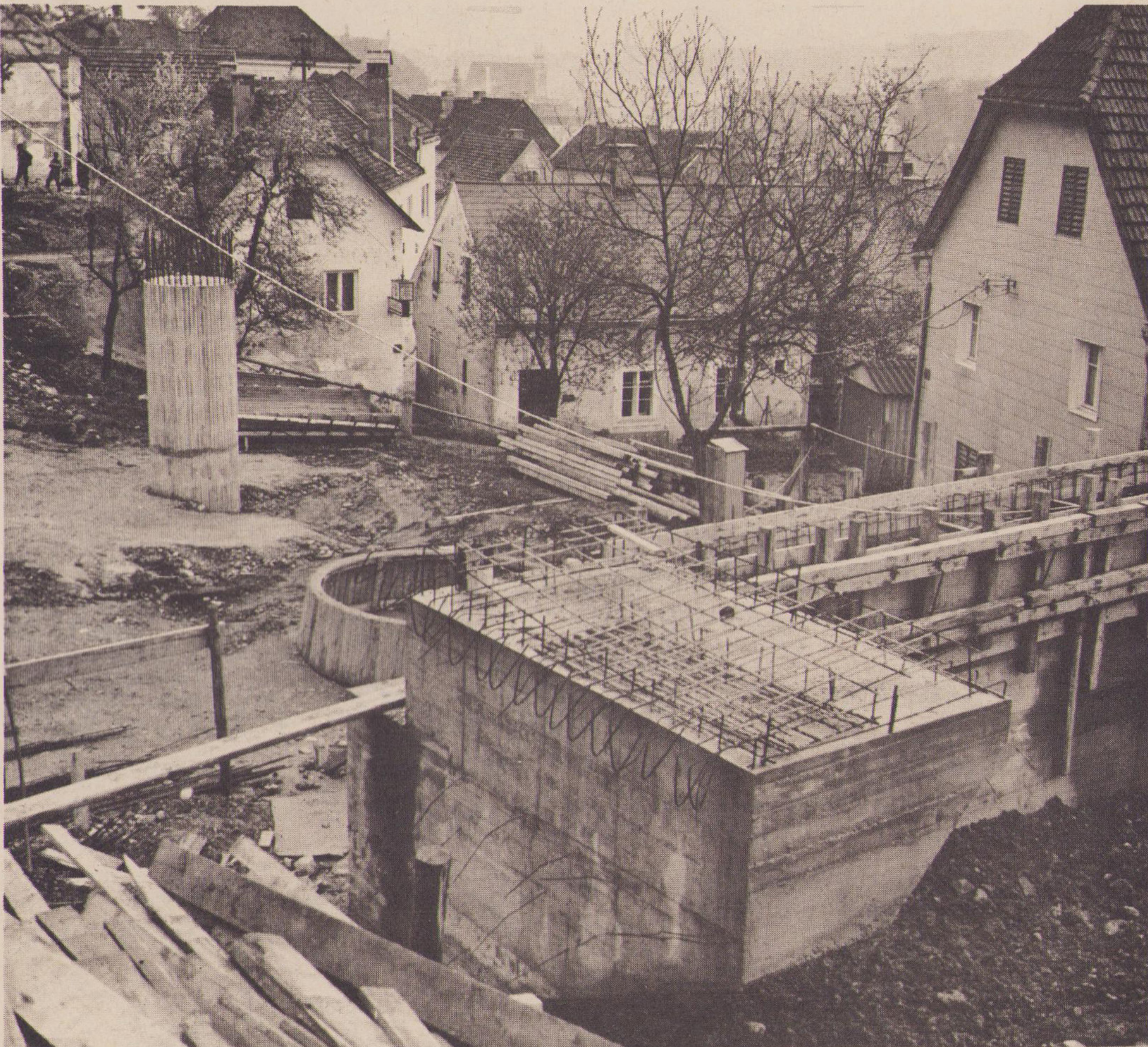
Der zweite Schwerpunkt im Zuge des Baues Seifentruhe liegt beim Bau der 62 m langen Straßenbrücke, mit welcher die Aichetgasse überquert wird.
