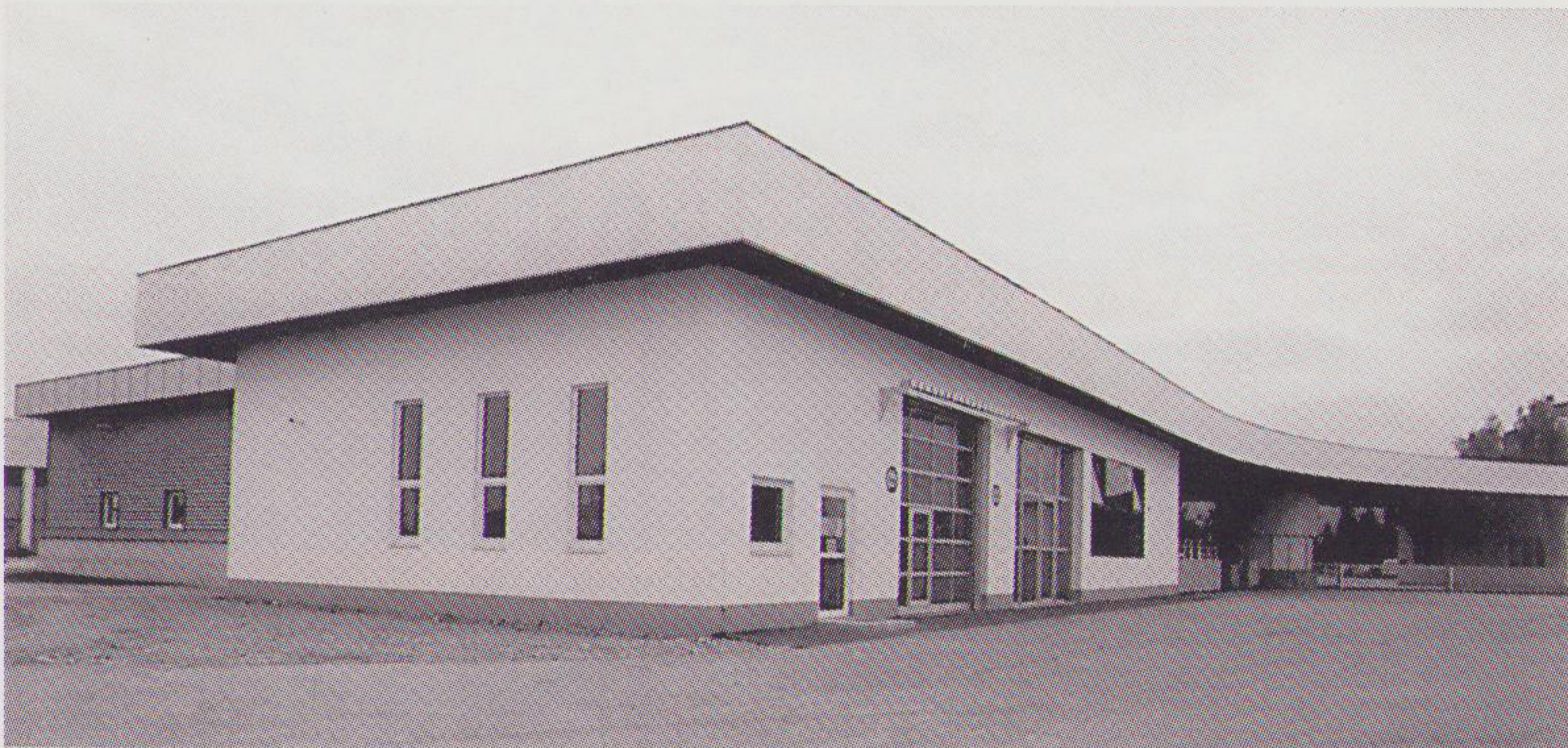
Kommunalzentrum: Bus-Waschanlage und Kfz-Prüfstelle des Landes.
