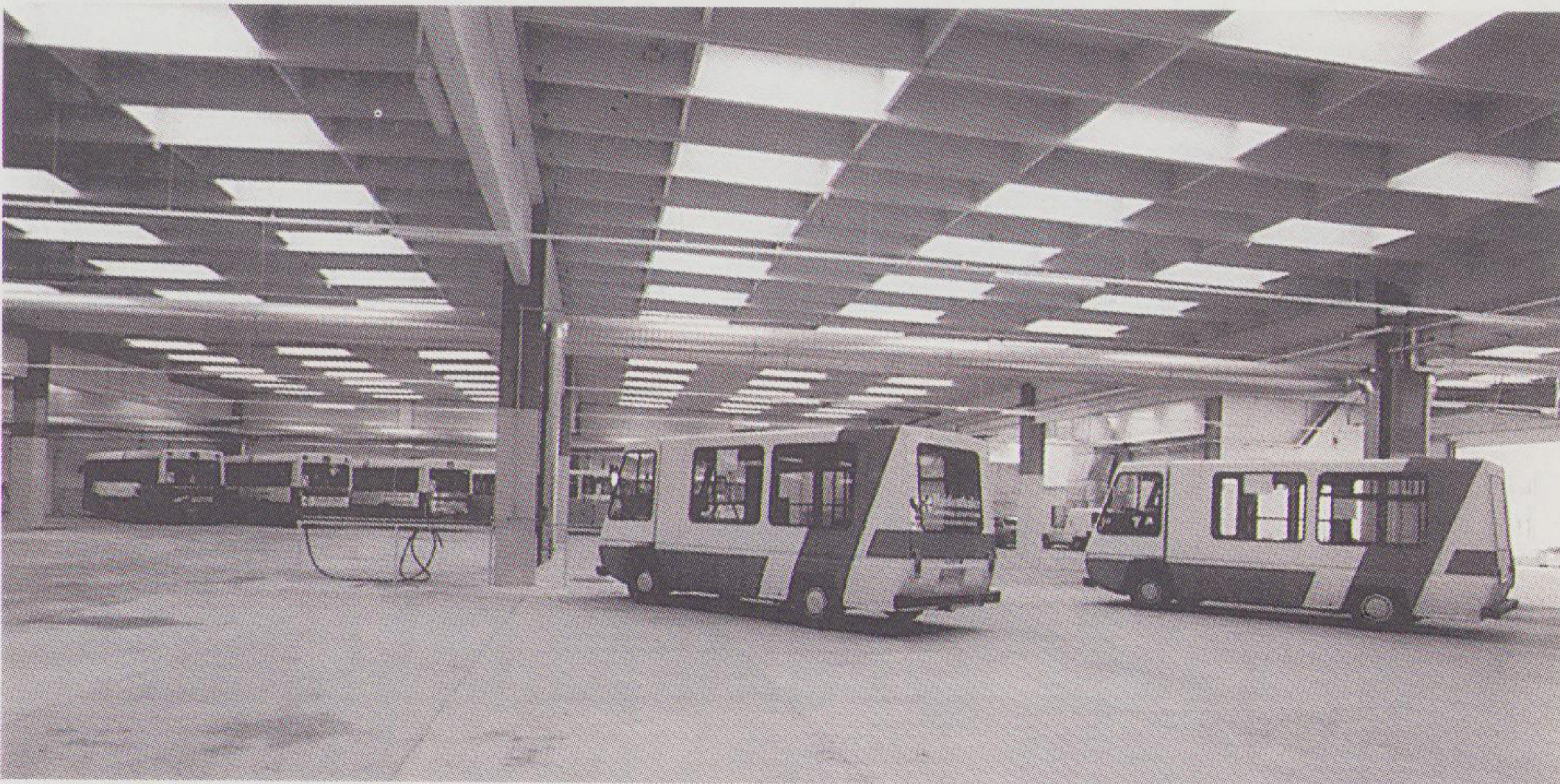
Blick in die Bushalle im neuen Kommunalzentrum.
