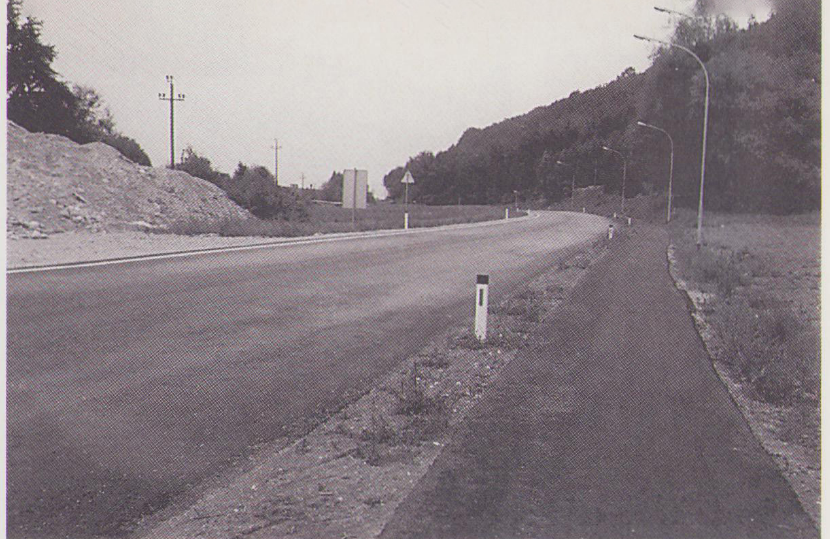
Ausbau der Gußwerkstraße.
