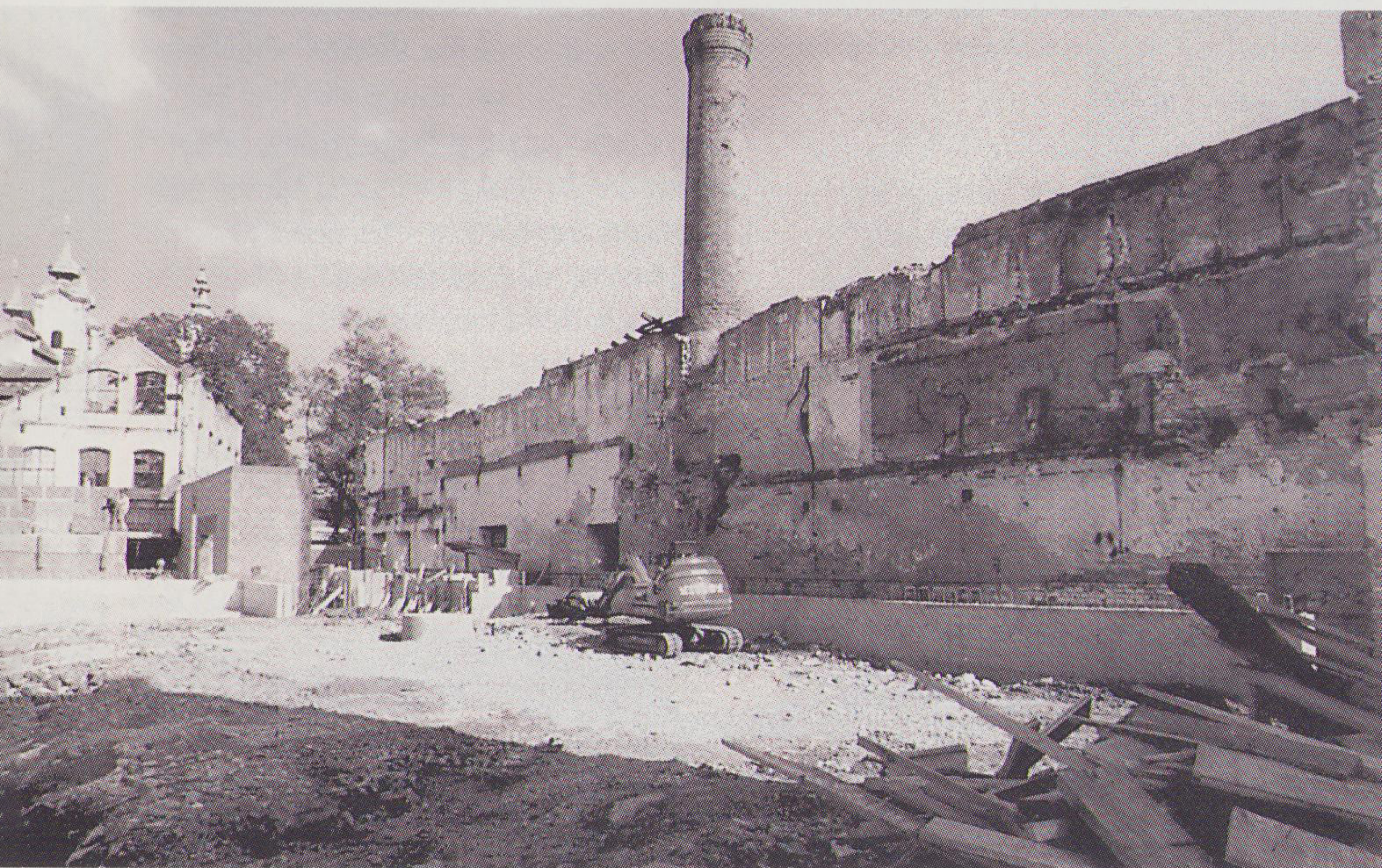
Die historischen Schornsteine werden in den Neubau integriert.
