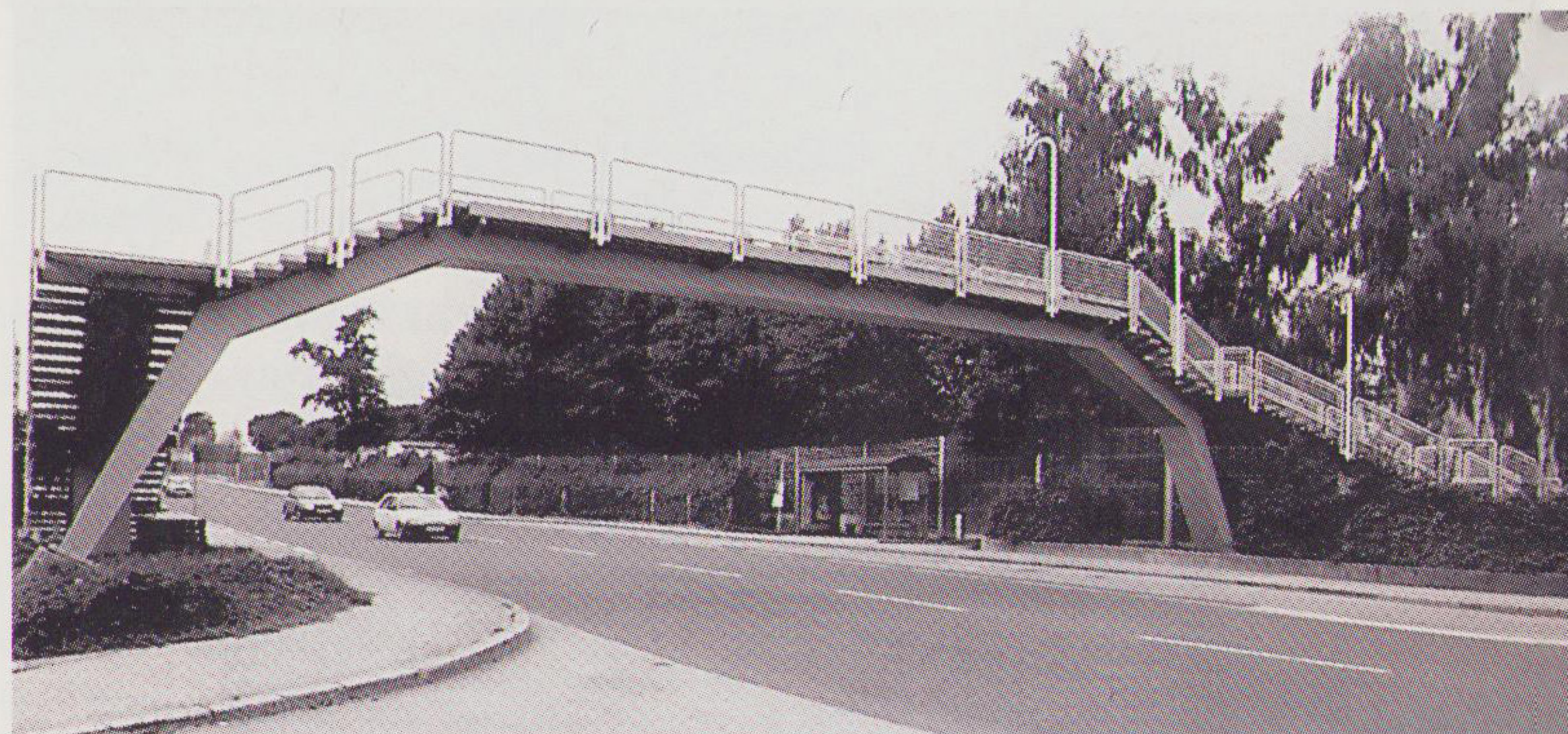
Der erneuerte Steg beim Möbelhaus Leiner.
