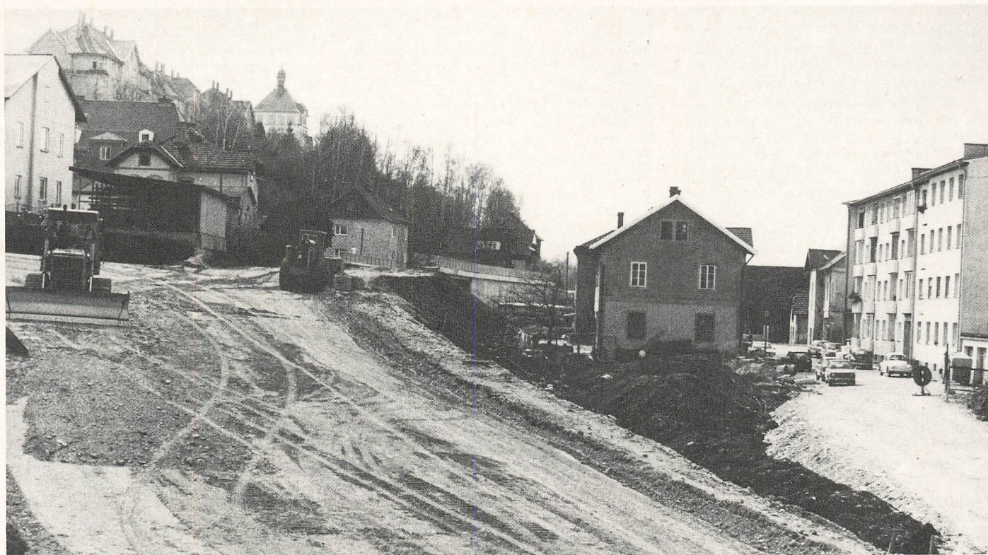
Blick auf die Baustelle der Märzenkellerumfahrung mit der geplanten Auffahrt über die Katzenwaldgasse (rechts im Bild) zu den Steyr-Werken und auf die Ennsleite. Nach der bisherigen Planung soll der Verkehr direkt am viergeschossigen Wohnhaus an der Katzenwaldgasse vorbeifließen. Die Stadt Steyr will nun bei der Landesbaudirektion erreichen, daß eine Lösung gefunden wird, die auf die Interessen der Anrainer weitgehend Rücksicht nimmt.
