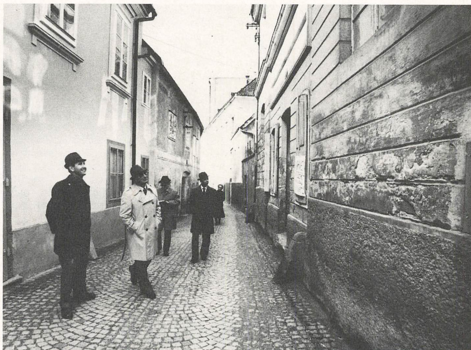
Eine Kanalverlegung außerhalb des Gerinnes ist besonders im Bereich Fabrikstraße mit größten Schwierigkeiten verbunden, weil zwischen den Häusern der Schwenkbereich für die Bagger nicht vorhanden ist.
