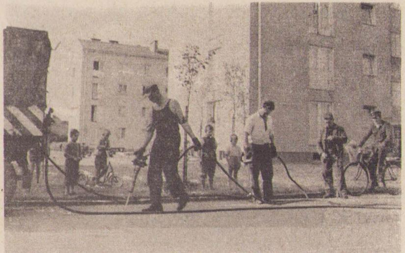
WÄHREND DIE BEIDEN ARBEITER MIT PRESSLUFTGERÄTEN DIE BOHRUNGEN VORNEHMEN, WERDEN DIE MESSUNGEN SELBST VON EINEM SPEZIALISTEN DURCHGEFÜHRT.
