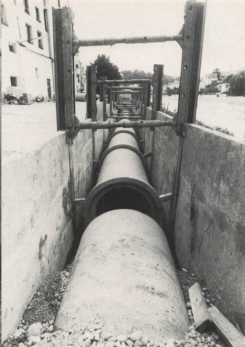
Stahlbetonrohre mit einem Meter Durchmesser, verlegt zwischen Oberer Kaigasse und Schönauberbrücke.
