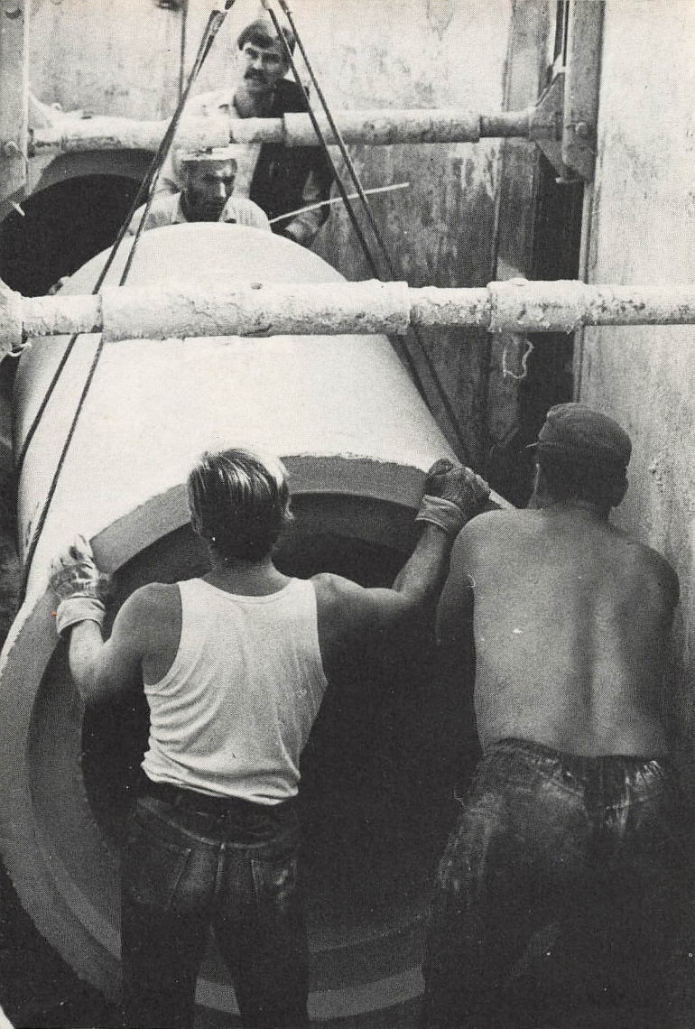
Der Einbau der Rohre ist Präzisionsarbeit. Die Rollringdichtung muß genau sitzen (Bild rechts).
