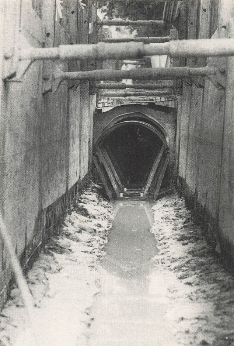
Fertiges Ortsbeton-Rohrprofil in 2,50 Meter Tiefe im Bereich des Kreisgerichtes.
