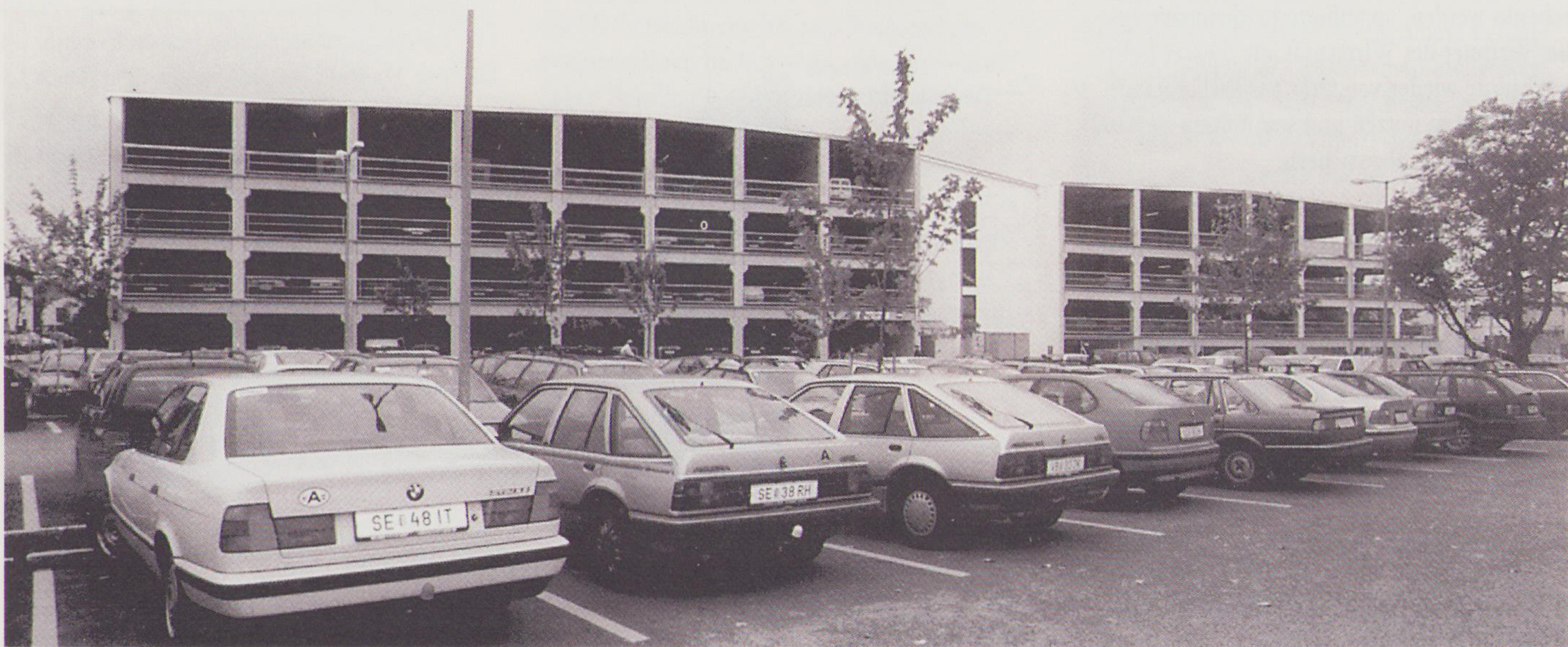
Neues Parkdeck für 800 PKW.
