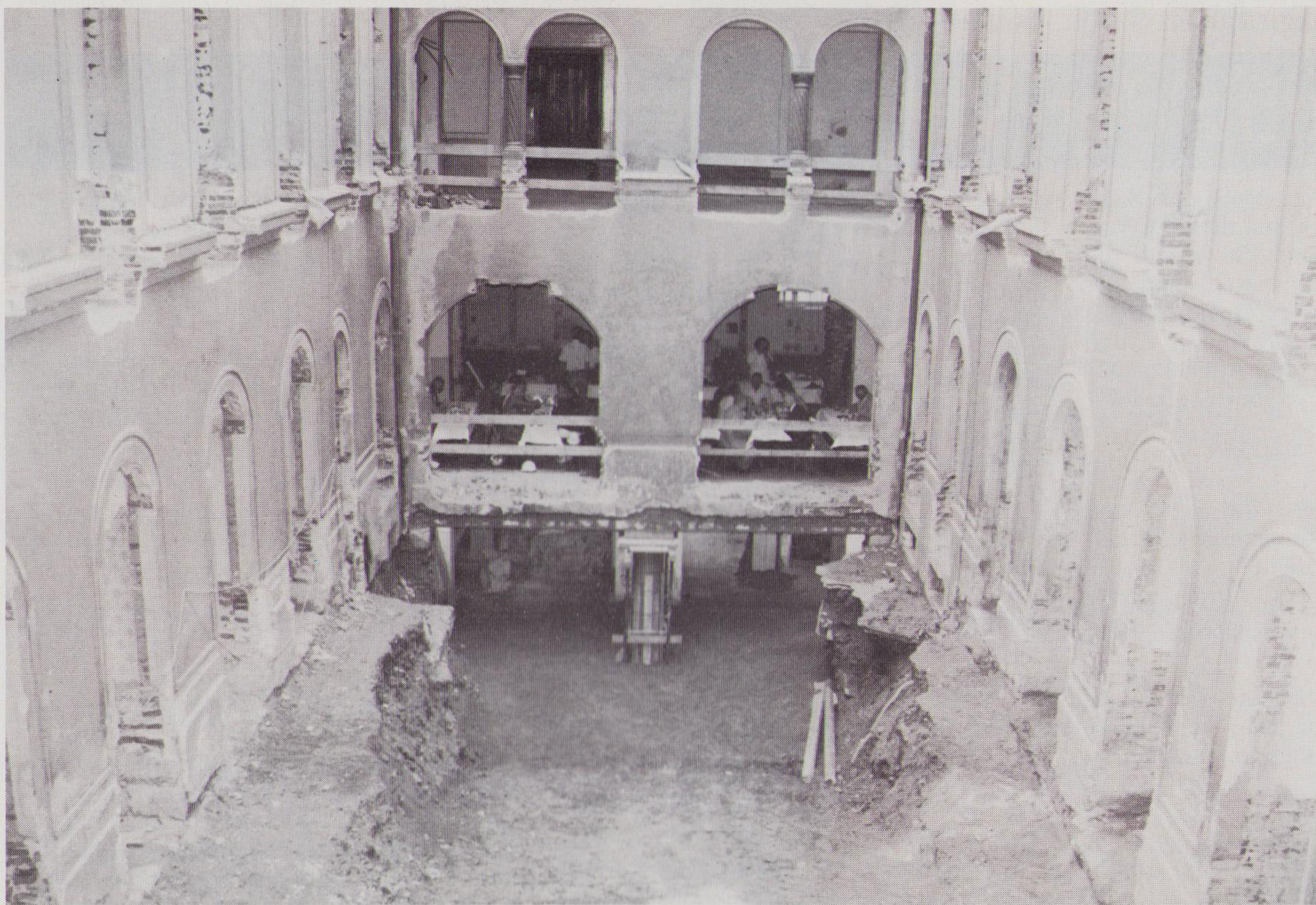
Blick auf die Baustelle der künftigen Stadtplatzpassage. Zum Bild links unten: Bürgermeister Schwarz und Franz J. Hartlauer, der Bauherr, lockerten das letzte Mauerstück als symbolischen Durchbruch zur neuen Fußgeherpassage.
