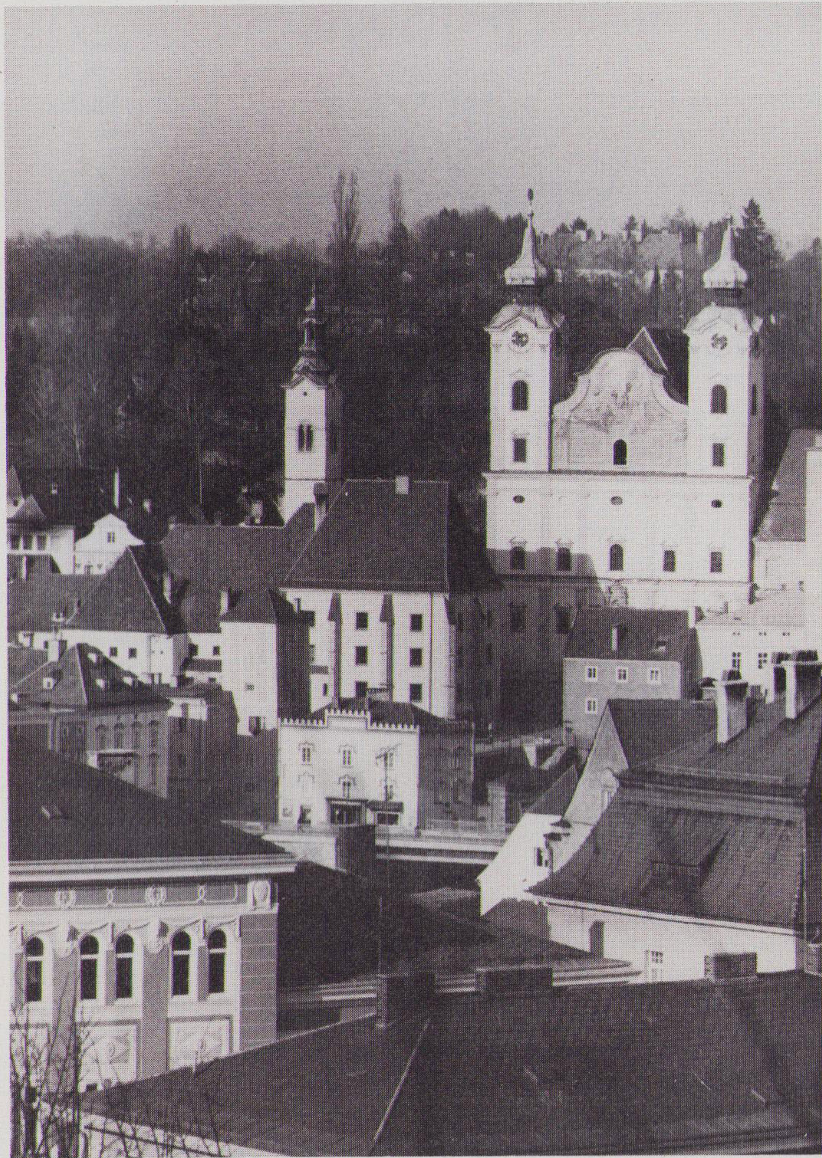
Die Fassade der Kirche St. Michael mit ihren zwei Türmen prägt das Stadtbild in Zwischenbrücken. Foto: Hartlauer
