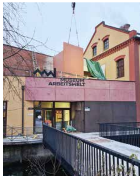
Das Veranstaltungszentrum im Museum Arbeitswelt an der Wehrgrabengasse ist neu gestaltet worden.
