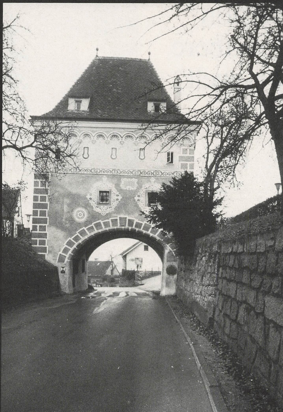
Das 1613 erbaute Schnallentor, ein besonders reizvoller niedriger Torturm über der Gleinker Gasse mit Keildach und Kratzputzornamentik, strahlt nun wieder in neuem Glanz. Die umfassende Restaurierung war notwendig, weil das Bauwerk stark unter dem Durchzugsverkehr gelitten hatte.
