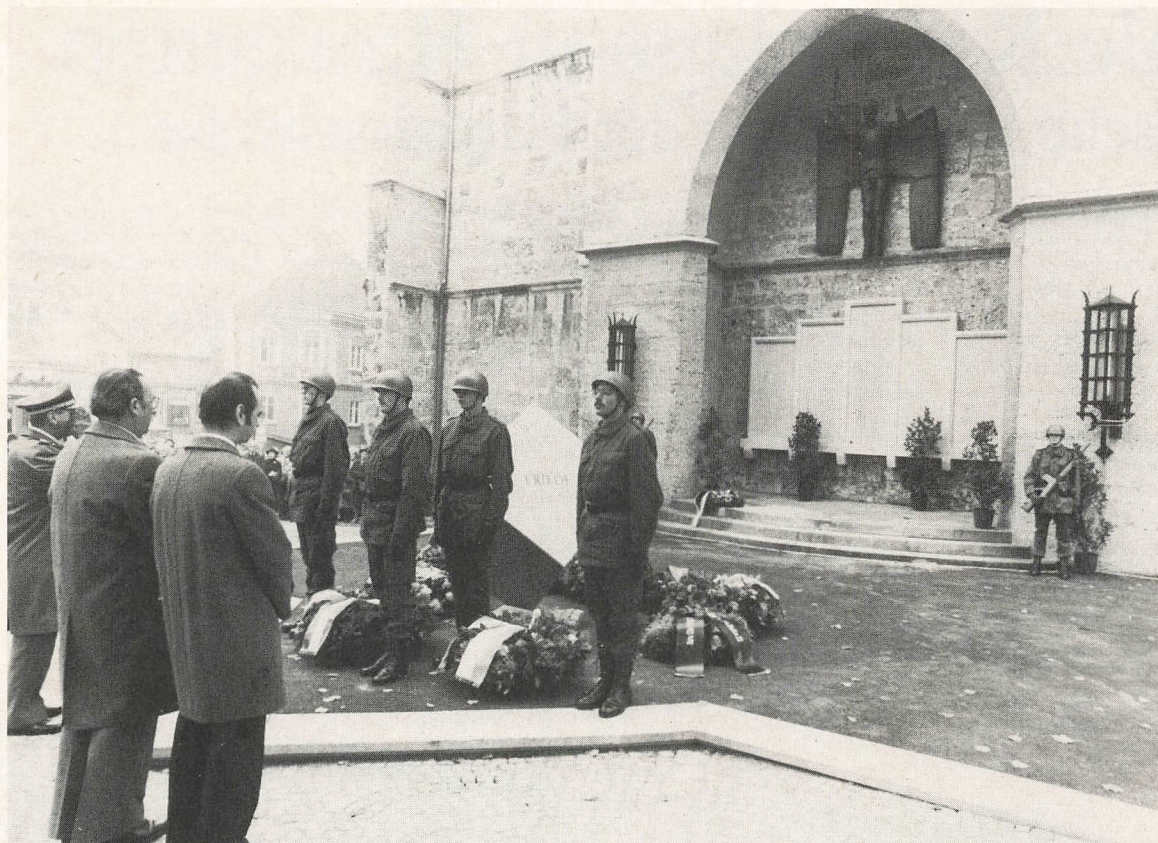
Im Zuge der Errichtung der neuen Gedenkstätte wurde die Westfassade der Stadtpfarrkirche restauriert, die Dachdeckung des Westwalls erneuert und um den Brunnen auf dem Brucknerplatz ein Stöckelpflaster angelegt. Außerdem wurde in den Brunnen eine neue Umwälzanlage eingebaut. Altstadt-leuchten, die das Schloß Lamberg, die Berggasse und die Pfarrgasse schmücken, stehen nun auch auf dem Brucknerplatz. Für die Gedenkstätte und die genannten Restaurierungen investierte die Stadt 1,634.000 Schilling. Fotos: Hartlauer
