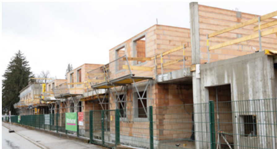
▲ Die Bauarbeiten für das zukunftsweisende Wohnprojekt Unsereins im Stadtteil Tabor laufen auf Hochtouren. Im hier abgebildeten Bereich an der Hanuschstraße entstehen 33 altersgerechte Einheiten für Vitales Wohnen. Ab 1. April kann man sich bei der GWG dafür anmelden.
