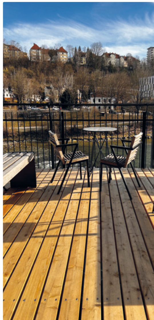
▲ Rechtzeitig vor Frühlingsbeginn konnte die Sanierung der beliebten Aussichtsterrasse beim Neutor abgeschlossen werden.
