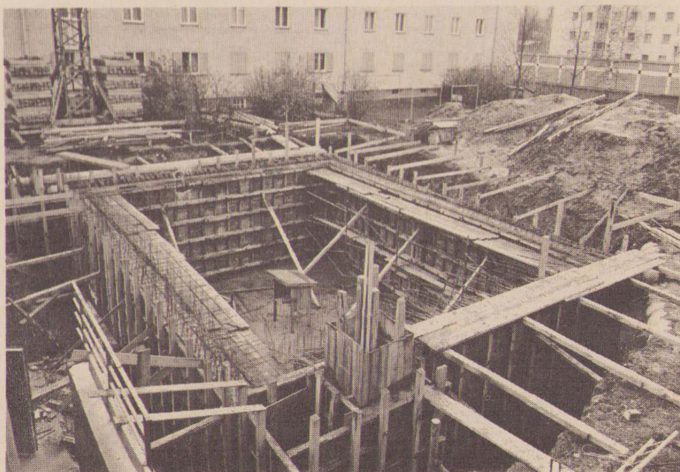
BAUGRUBE FÜR DEN ÖLTANK
