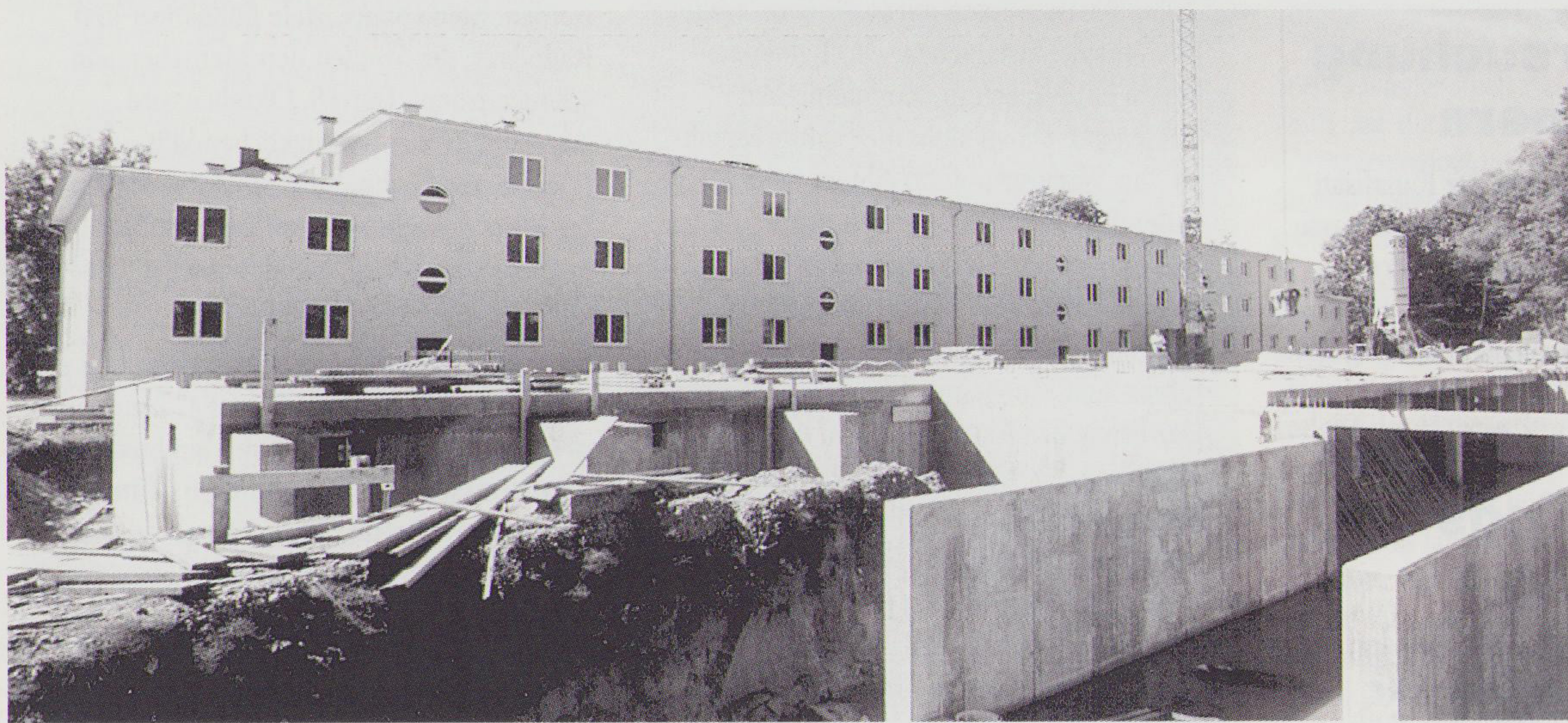
An der Wehrgrabengasse baut die STYRIA 45 Wohnungen in Größen von 50 bis 90m 2 . Die Stadt fördert das Projekt mit 1.360.000 S und hat dafür das Einweisungsrecht für 18 Wohnungen. Der Bau soll bis Ende des Jahres fertig sein.
