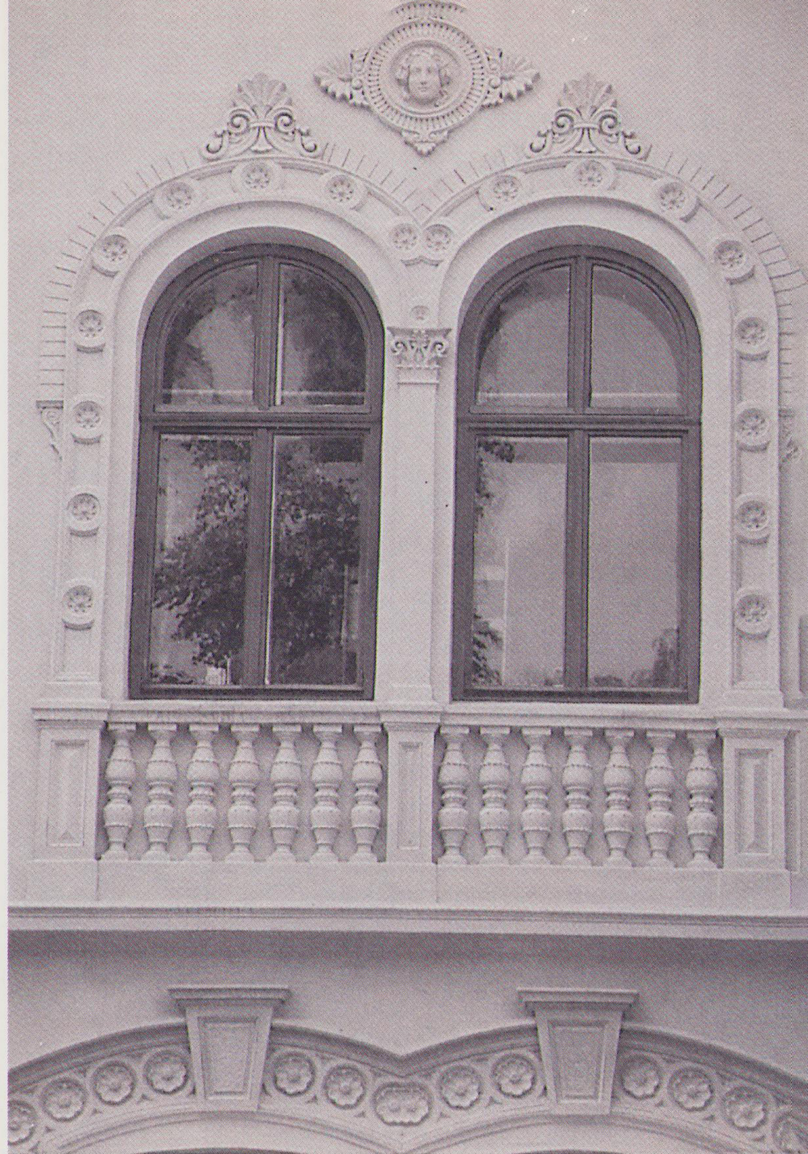
Fassadendekor mit Terracottastuckteilen.
