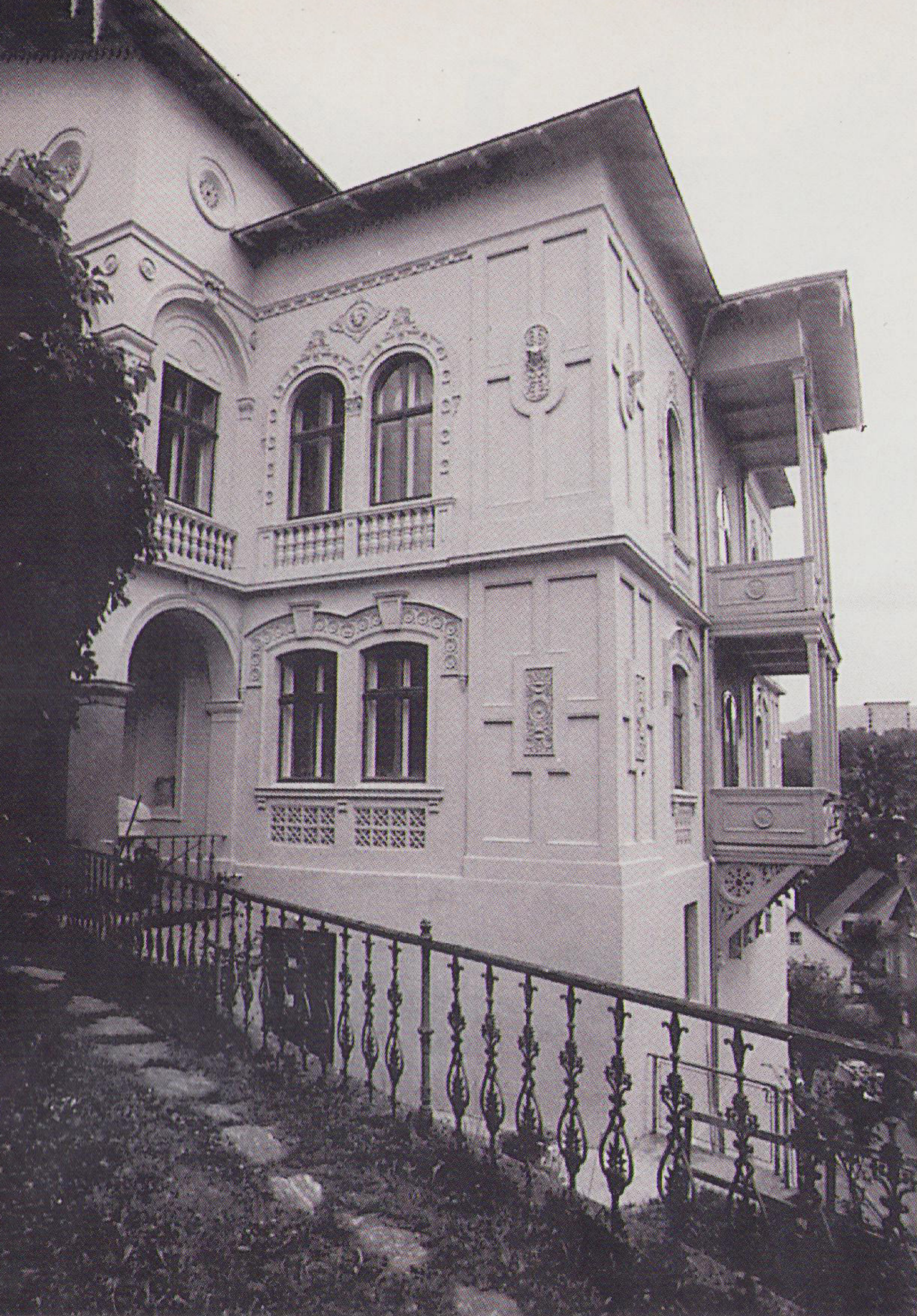
Der Balkon wurde in überlieferter Form aus Eichenholz gestaltet.
