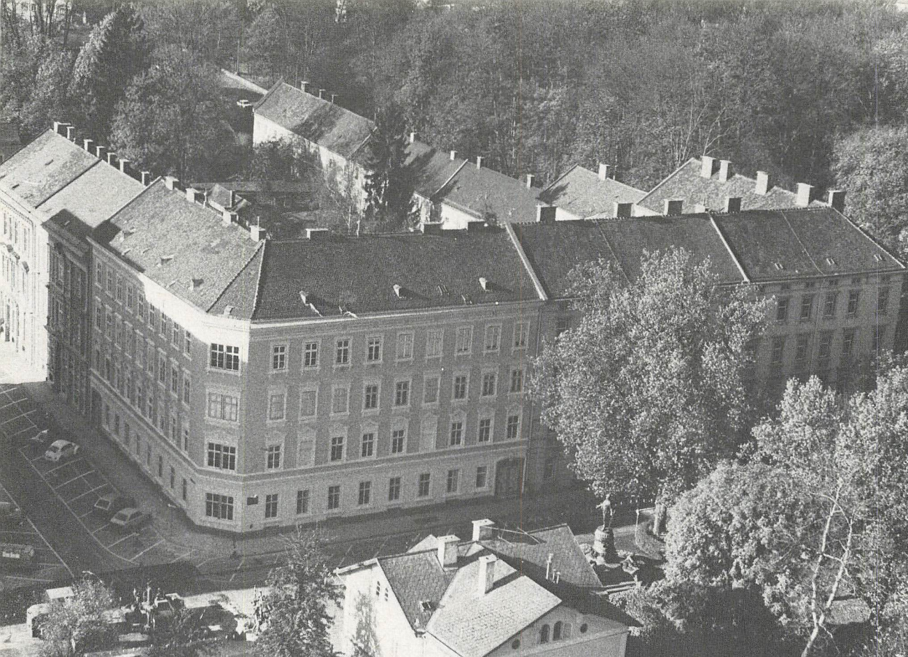
In den Wohnhäusern Promenade 8 bis 10 wurden mit einem Kostenaufwand von 1,2 Millionen Schilling die Fenster erneuert, Fassaden gefärbelt und Dächer repariert. Fotos: Hartlauer
