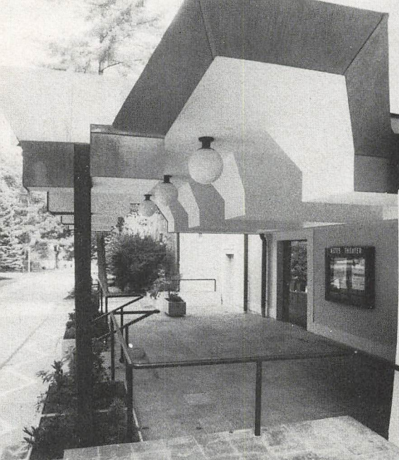
Durch die Verlegung des Theatereinganges von der Berggasse auf die Handel-Mazzetti-Promenade wurden Pausen- und Garderobenräume gewonnen.
