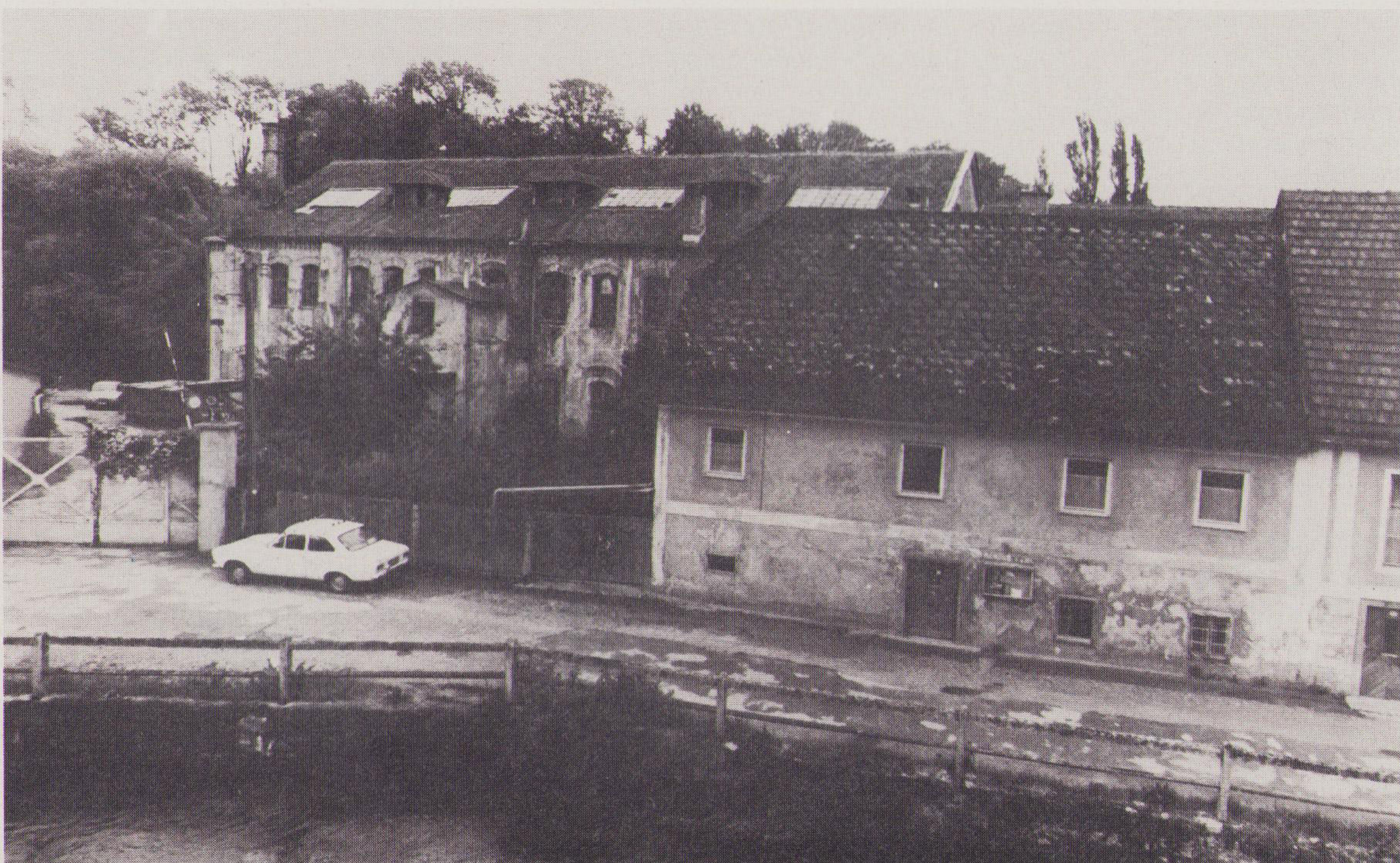
Das hintere Gebäude soll als Museum adaptiert werden.
