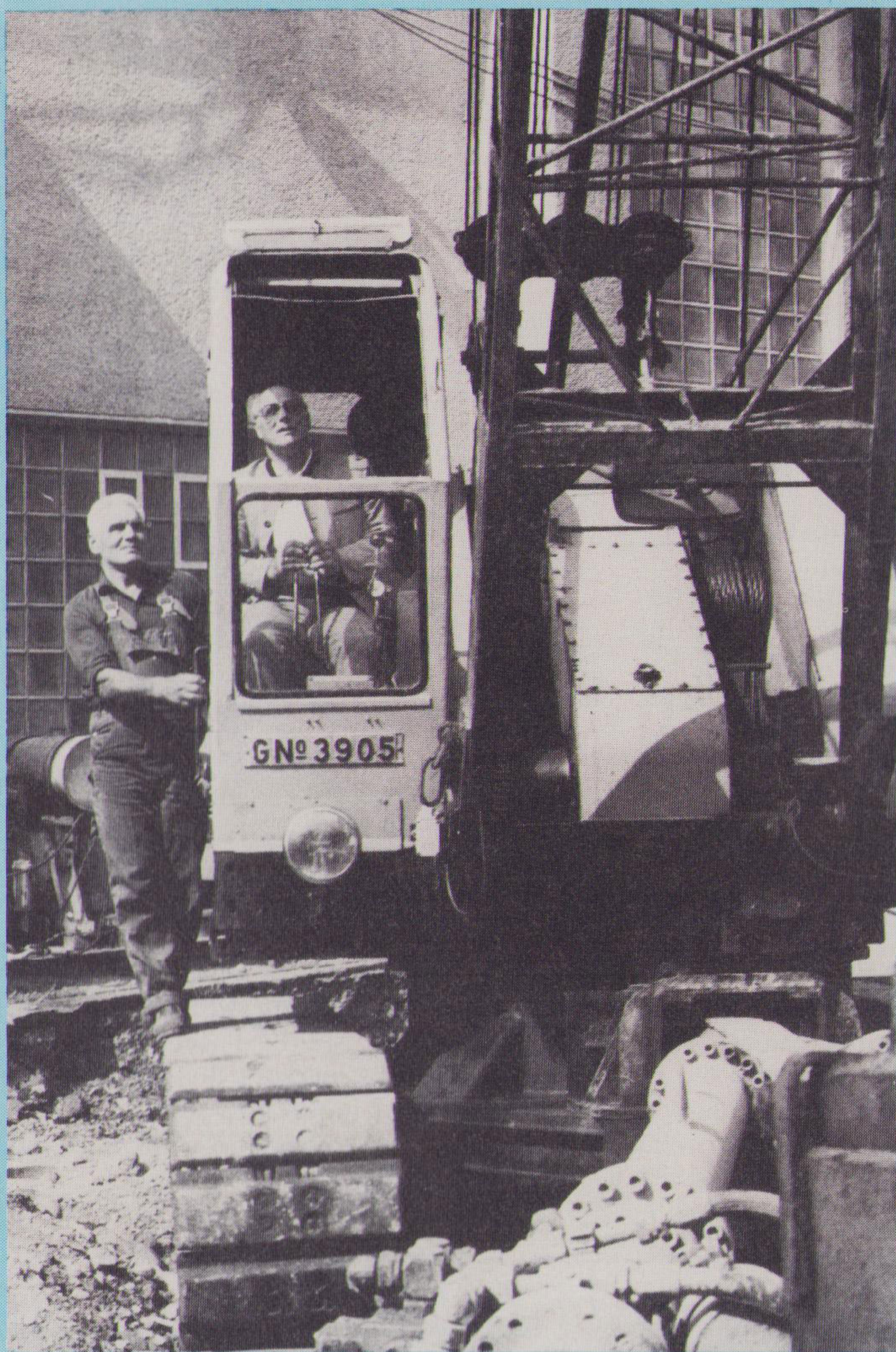
Bürgermeister Weiss setzt symbolisch das Gerät in Gang, mit dem die Pfähle für den Tunnelbau eingebracht werden.
