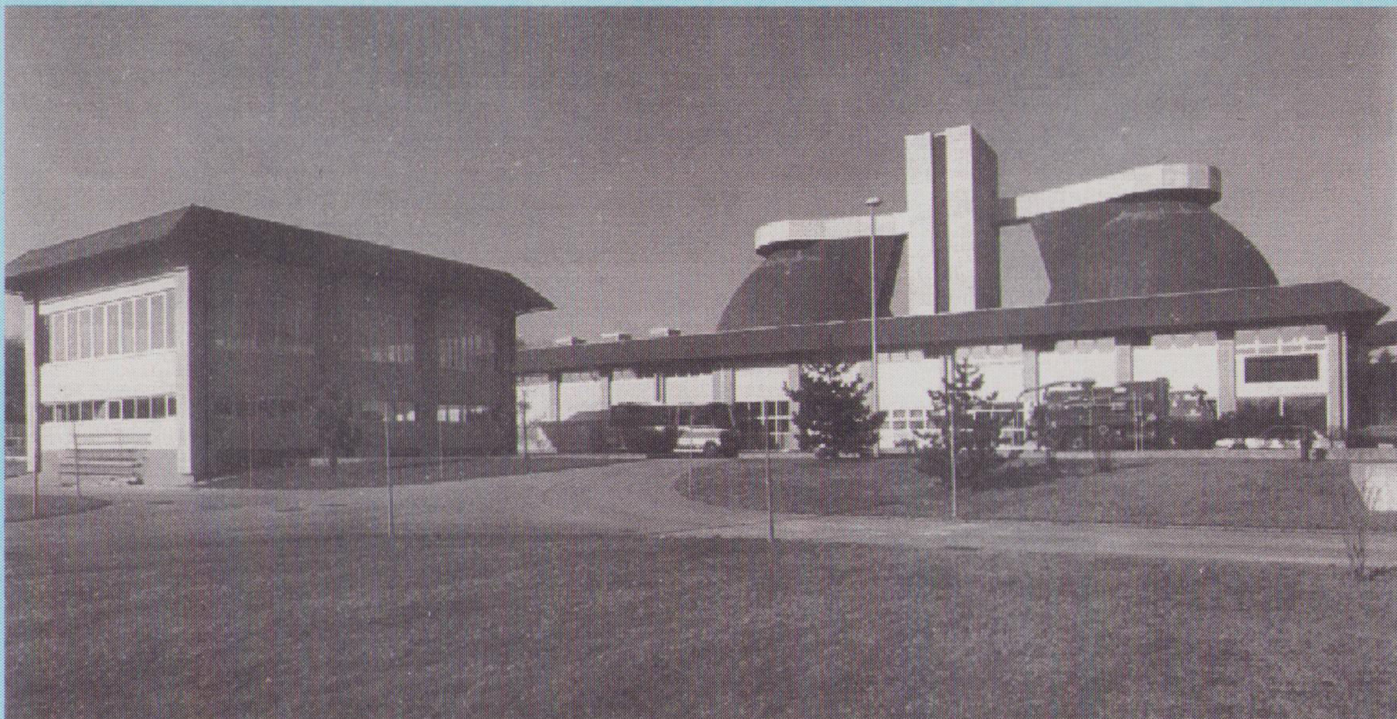
Das 74 Meter lange Betriebsgebäude der zentralen Kläranlage.
