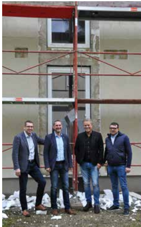
Überzeugten sich vom Fortschritt auf der Baustelle – im Bild von links: Bürgermeister Markus Vogl, Wohnbau-Referent Stadtrat Christian Baumgarten sowie die GWG-Geschäftsführer Hans-Peter Bühringer und Robert Weidinger.
