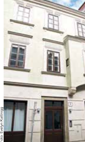
Fassaden- und Fenstersanierung, Dr. Ingo Forstenlechner, Sierninger Straße 8
