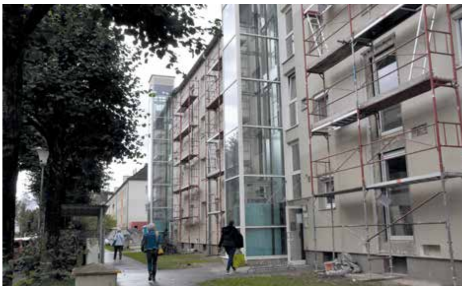
An den GWG-Wohnhäusern Hafnerstraße 7, 9 und 11 im Stadtteil Ennsleite werden derzeit etwa 40 Balkone errichtet.
