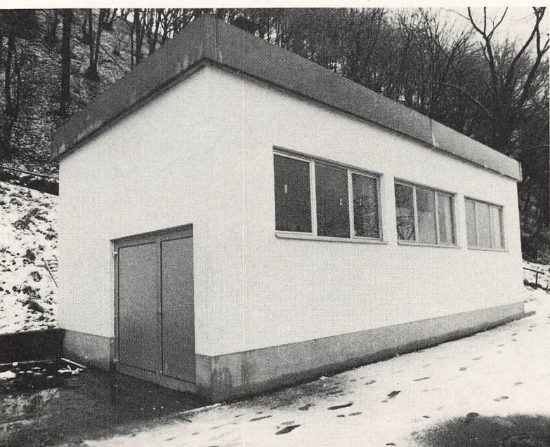
Pumpstation A am Lauberleitenweg.
