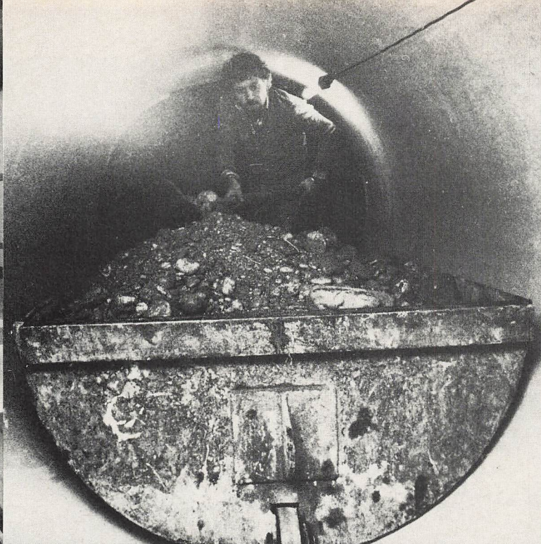
Schwere Handarbeit im Kanalrohr
