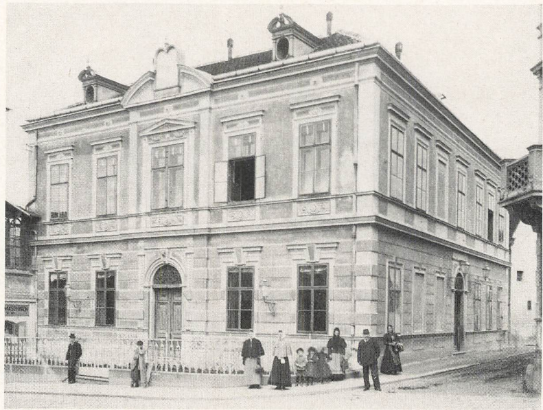
Ehemaliger Judentempel in Steyr an der Ecke Bahnhofstraße – Pachergasse. Auf dem Dachgiebel die Darstellung der Gesetzestafeln.
