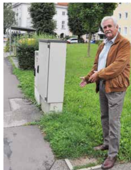
Hier wird für den Münichholzer-Markt ein Strom- und Wasseranschluss geschaffen.
