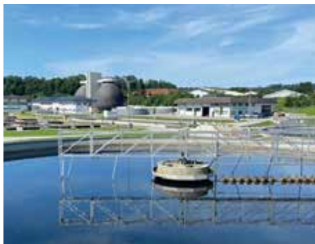
Nach einer 19,8 Millionen Euro teuren Generalsanierung ist die Kläranlage wieder auf dem aktuellen Stand der Technik.
