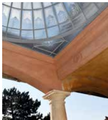
Besonders eindrucksvoll ist die Glaskuppel mit 157 Ätzglasseiben. Die Restaurierung erledigten Fachleute aus Deutschland.
