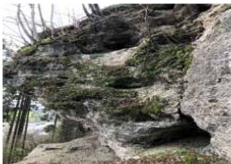
Absturzgefährdete Konglomeratblöcke, wie dieser, müssen abgetragen oder gesichert werden.
