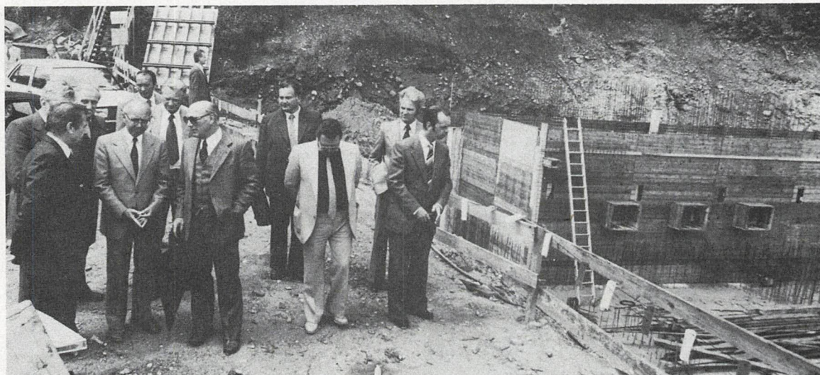
Bürgermeister Weiss zeigte dem Landesbaureferenten die gewaltigen Anstrengungen der Stadt Steyr und des Reinhaltungsverbandes beim Kanalbau. Rechts im Bild die Baustelle des Pumpwerkes des Sammlers A am Lauberleitenhang.
