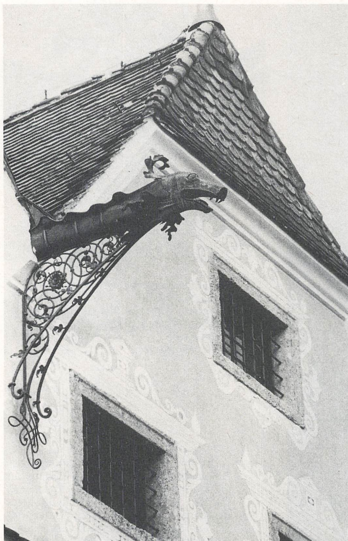
Aus dem Grabendach des Giebelpaares ragt der weithin sichtbare Wasserspeier, der von kunstvoll gearbeitetem Schmiedeeisen getragen wird.
