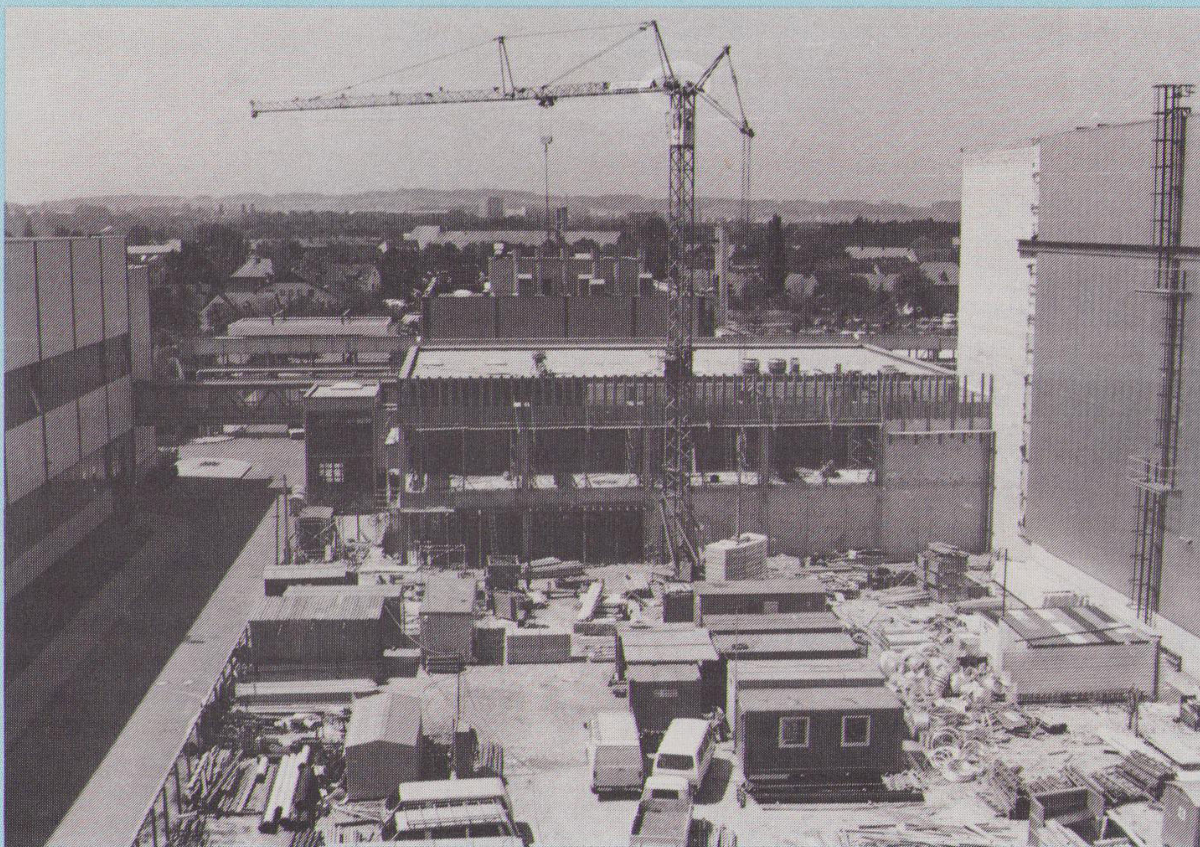
Zubau zum Kantinegebäude und neues Hochregallager (im Bild rechts) im Zuge der 2. Ausbauphase des BMW-Motorenwerkes, die derzeit im Gange ist. Werksfoto
