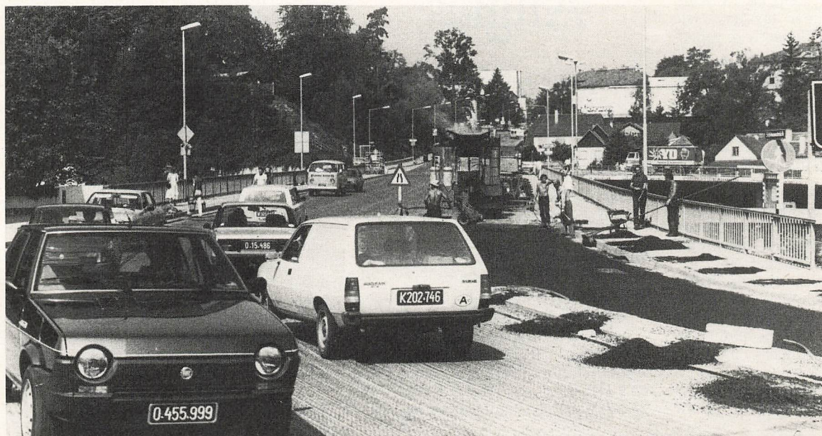
Mit einem Kostenaufwand von 4,2 Millionen Schilling werden Fahrbelag und Randbelagen der Schönauer- und Vorlandbrücke saniert. Die Kraftfahrer brachten für die Beschränkungen durch die Bauarbeiten viel Verständnis auf. Im Vordergrund des Bildes der abgefräste Belag, auf der rechten Fahrspur wird der neue Gußasphalt eingebracht.
