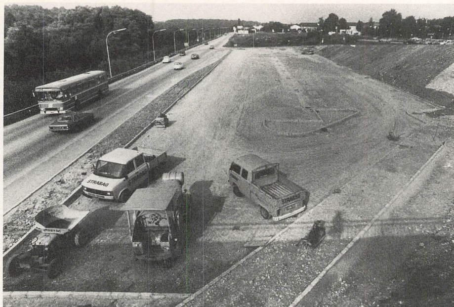
Der neue Parkplatz beim Krankenhaus im Rohbau.
