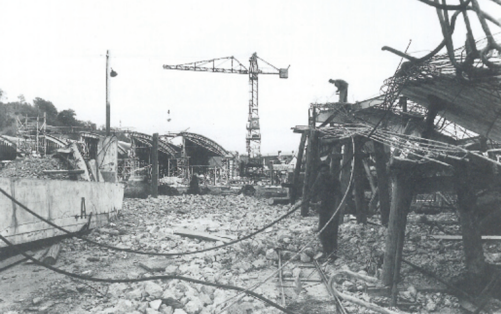
▲ In den durch Bombenangriffe schwer beschädigten Steyr-Werken wurde versucht, die Produktion wieder in Gang zu bringen. Unter anderem wurden auch Kochtöpfe und Feuerzeuge erzeugt.
