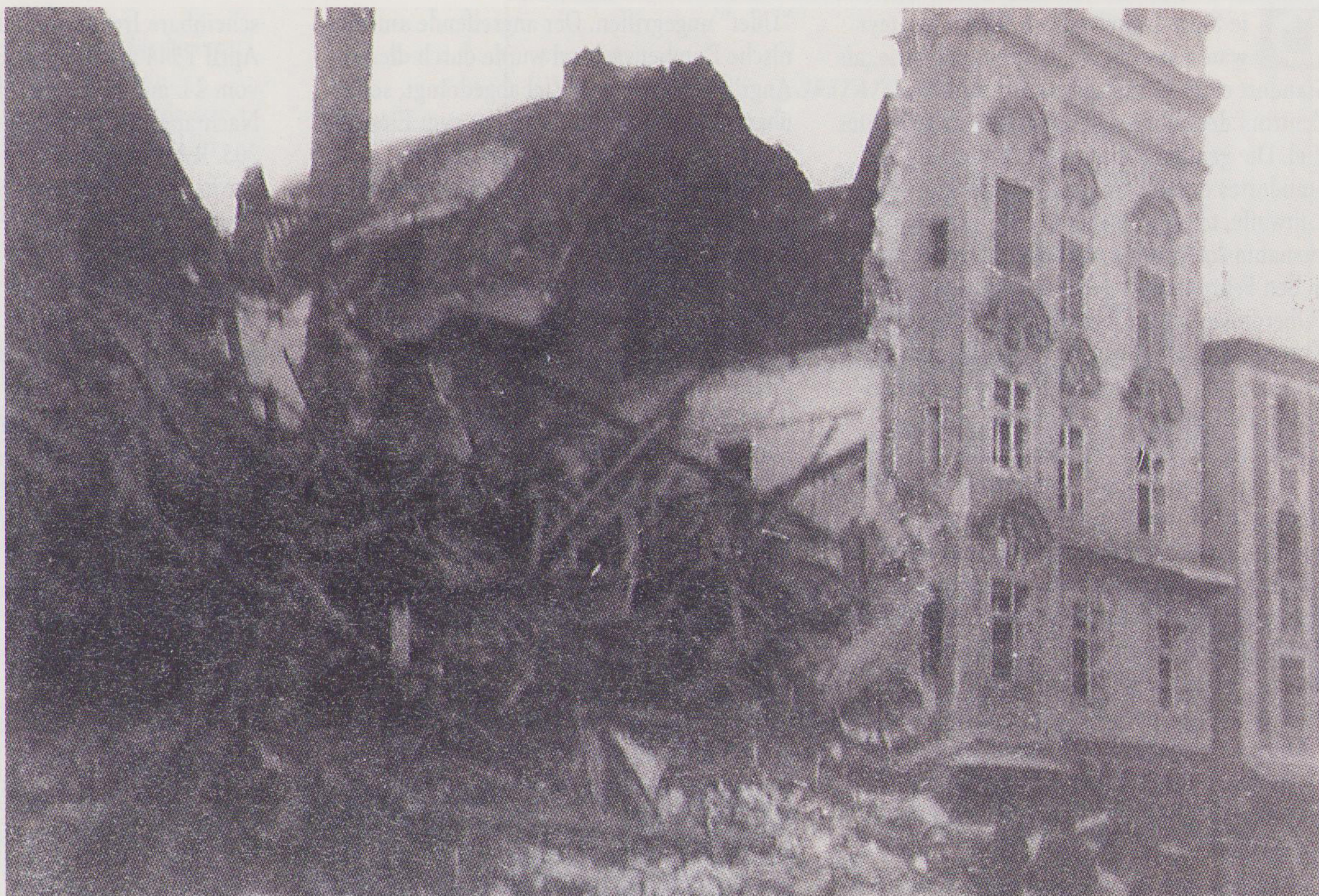
Das Haus Stadtplatz 12 nach dem Bombenangriff
