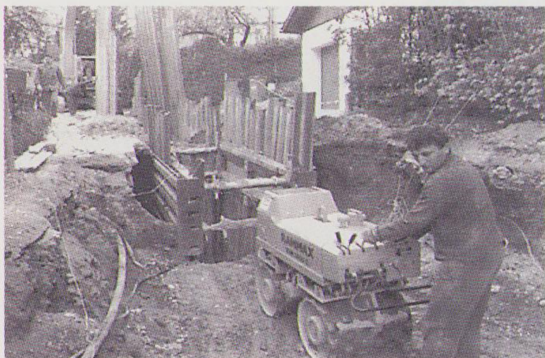
Kanalbau in der Marsstraße.
