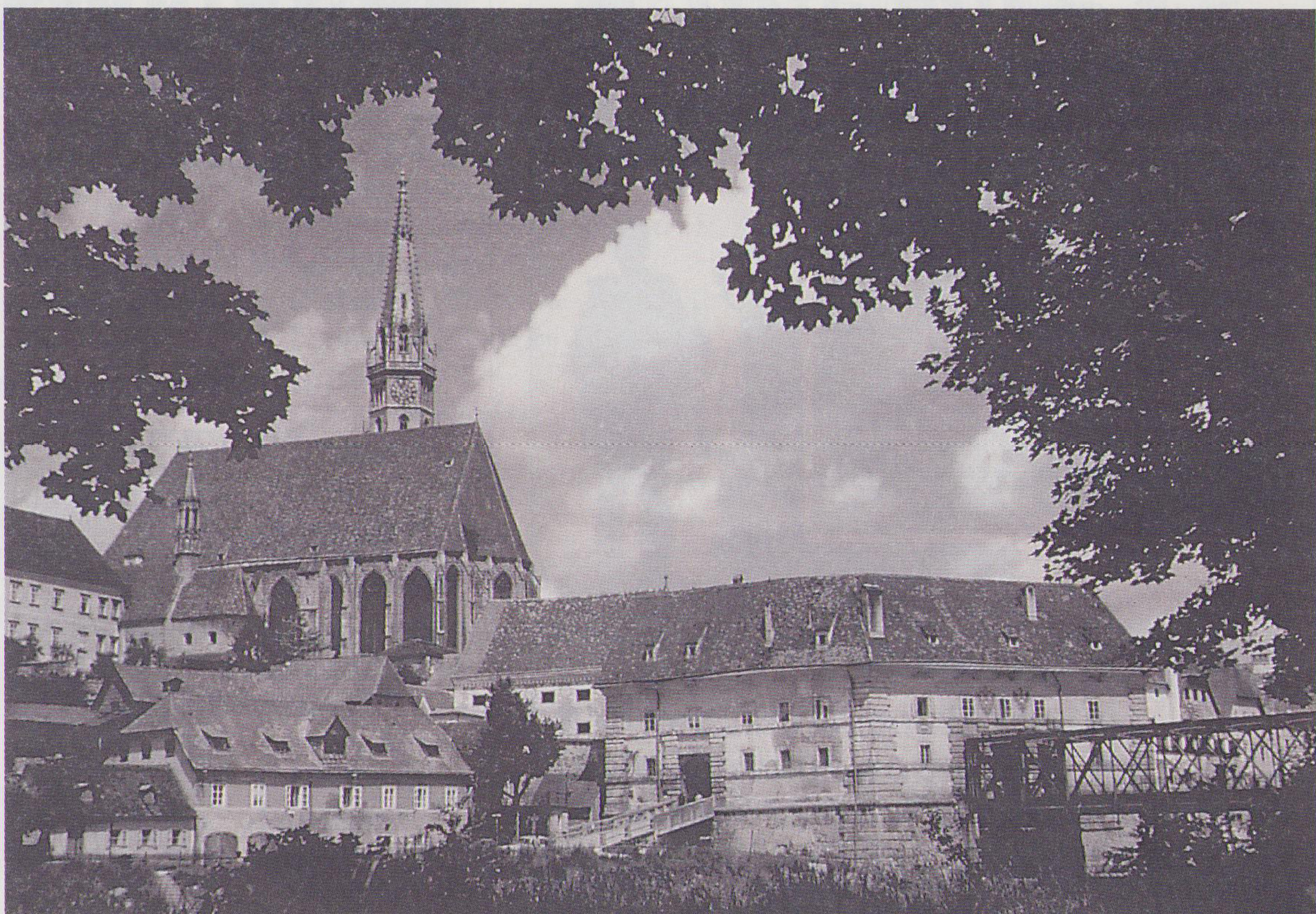
Das Neutor vor dem Bau der Vorlandbrücke.
