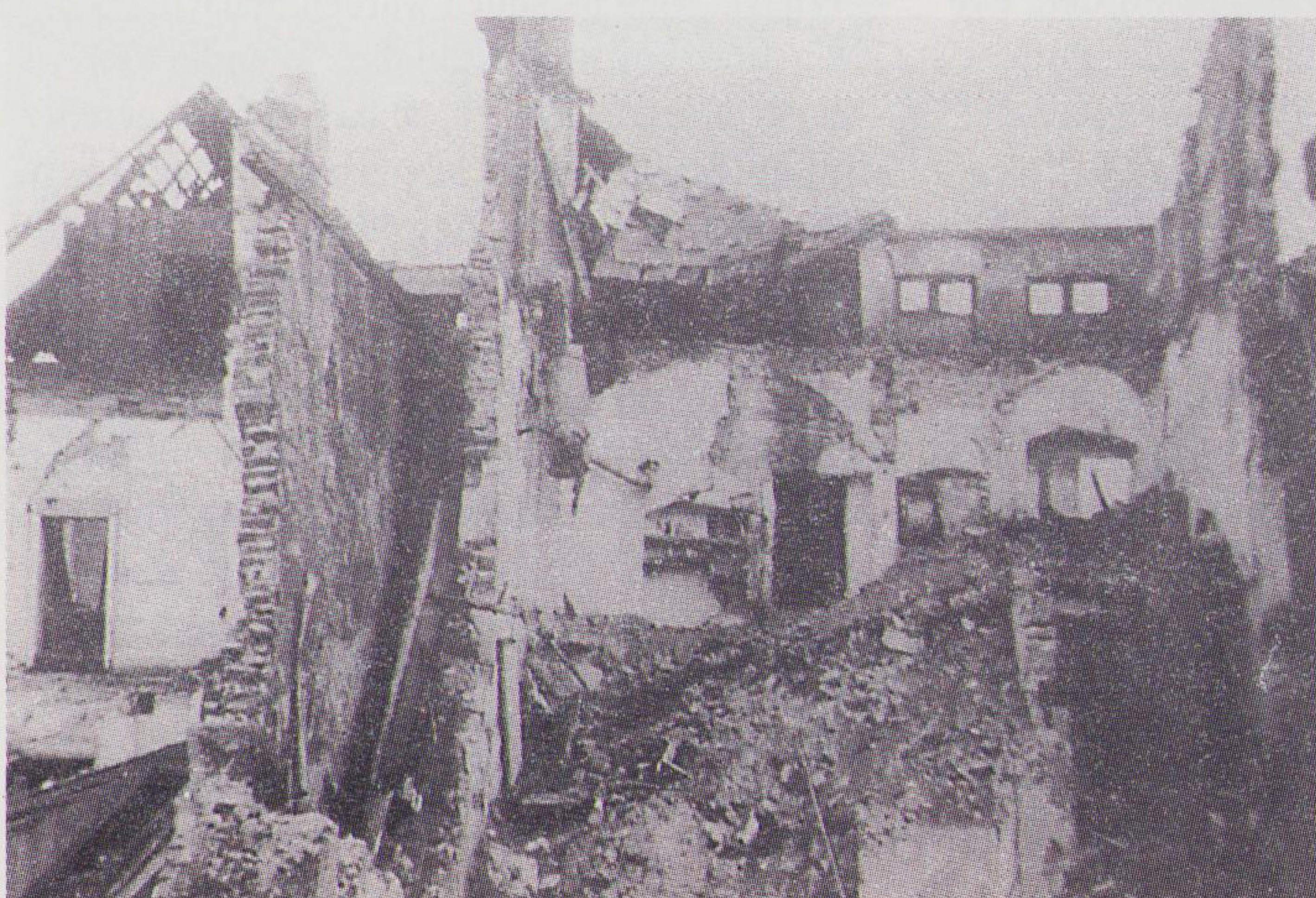
Zerstörte Häuser Enge 21 und 23.
