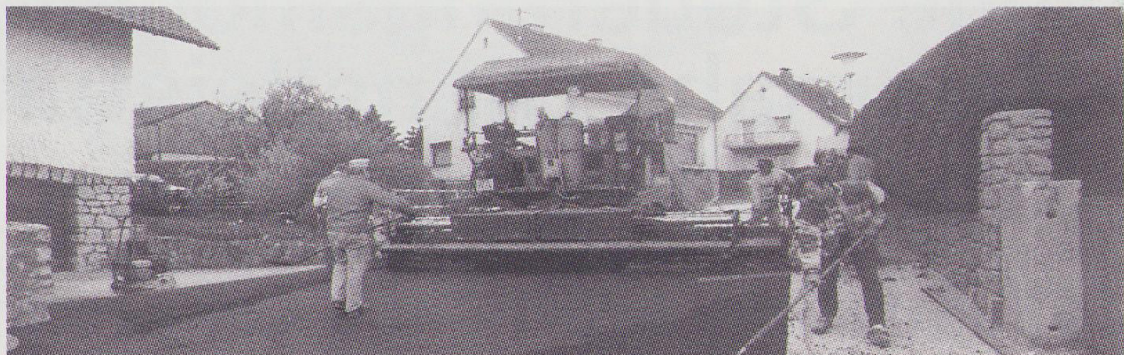
Asphaltierung der Goldbacherstraße in der Christkindlsiedlung.
