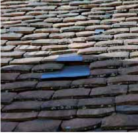
Die Dach-Unterkonstruktion war teilweise so morsch, dass Schäden an den Ziegeln nur mehr notdürftig von innen repariert werden konnten (mit Hilfe von Blechstreifen). Foto: Magistrat Steyr
