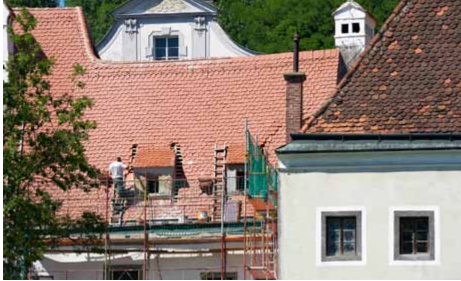
Durch die Verwendung neuer Ziegel (an der Flussseite) wird die Lebensdauer der Dachdeckung verlängert und somit der Aufwand für die künftigen, sehr schwierigen Reparaturen eingeschränkt.
