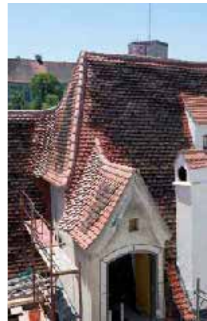
Sämtliche Gaupen und Kaminköpfe sind fachgerecht restauriert worden.
