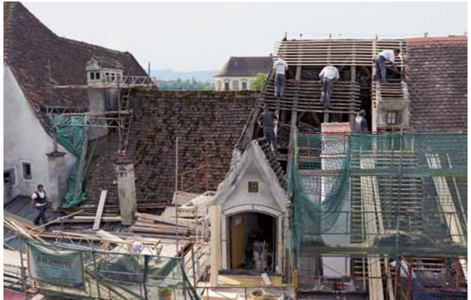
Dachdecker und Zimmerer erneuern die morsche Dachlattung.
