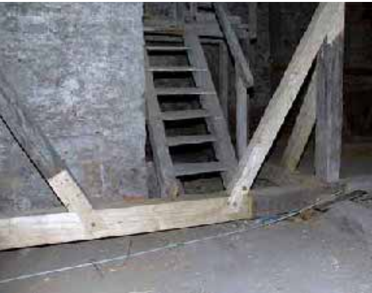
Ausgebessertes Dachgebälk – die morschen Teile sind von den Zimmerern ersetzt worden.
