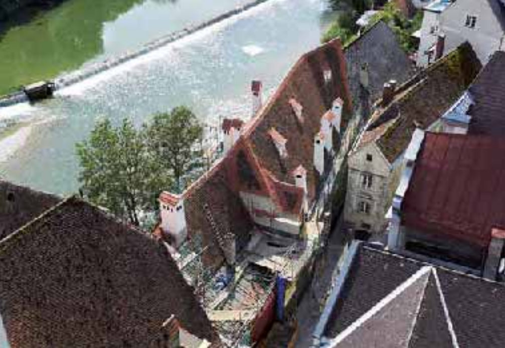
Blick vom Turm der Michaelerkirche auf das neue Dach des Bürgerspitals.
