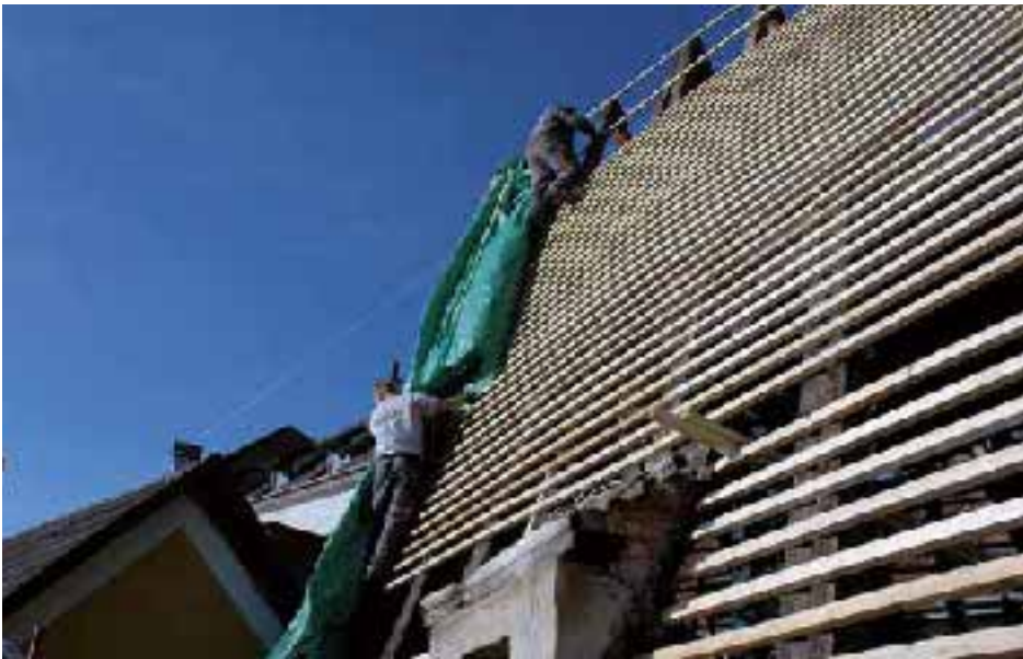
Unten: Dachdeckerarbeiten bei einem Neigungswinkel von 60 Grad.
