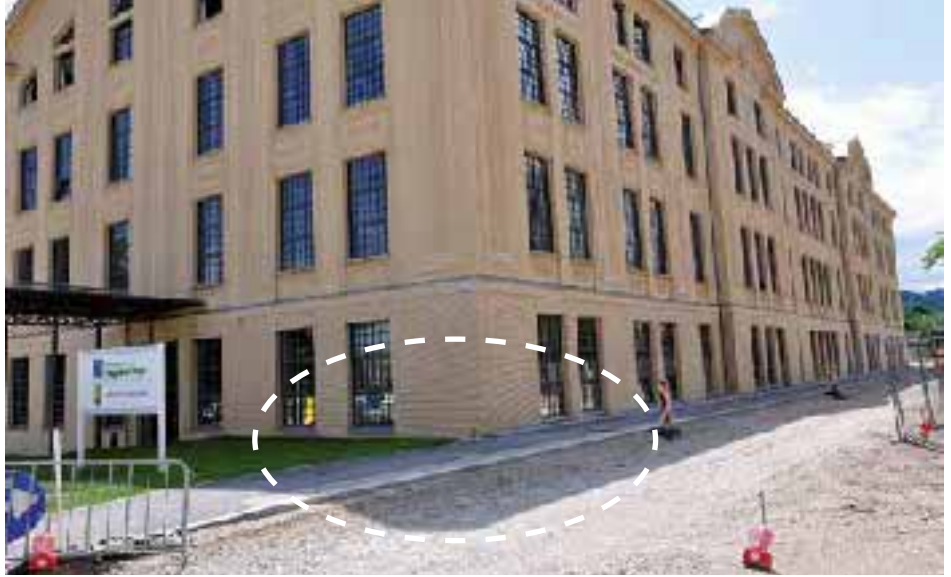
Das Amtsgebäude Reithoffer wird am 16. August an das städtische Busliniennetz angebunden. Die behindertengerechte Bushaltestelle (siehe Markierung) befindet sich dann direkt beim Eingang der Magistrats-Außenstelle.
