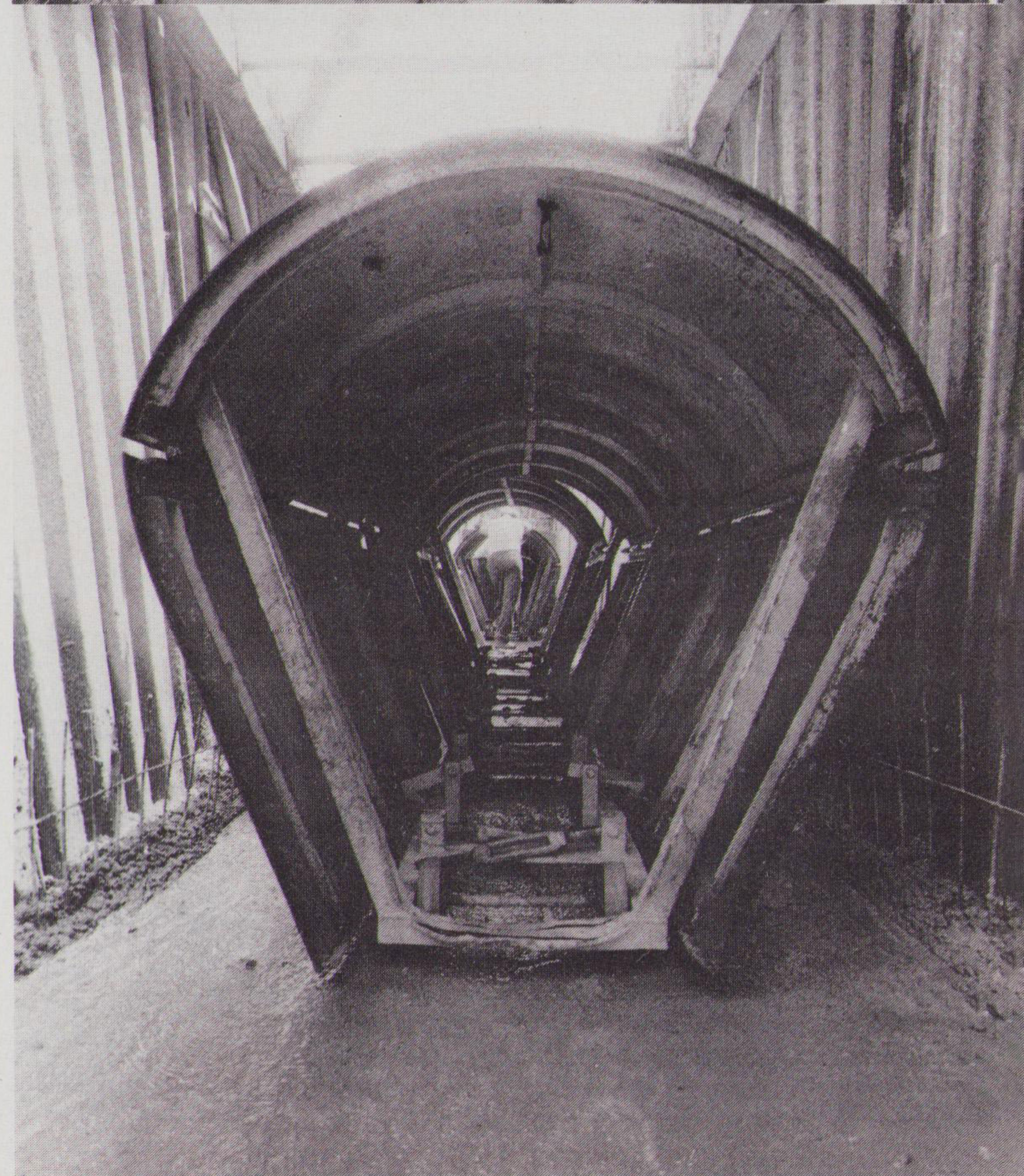
Stahlschalung für das Maulprofil, welches aus Ort beton hergestellt wird.
