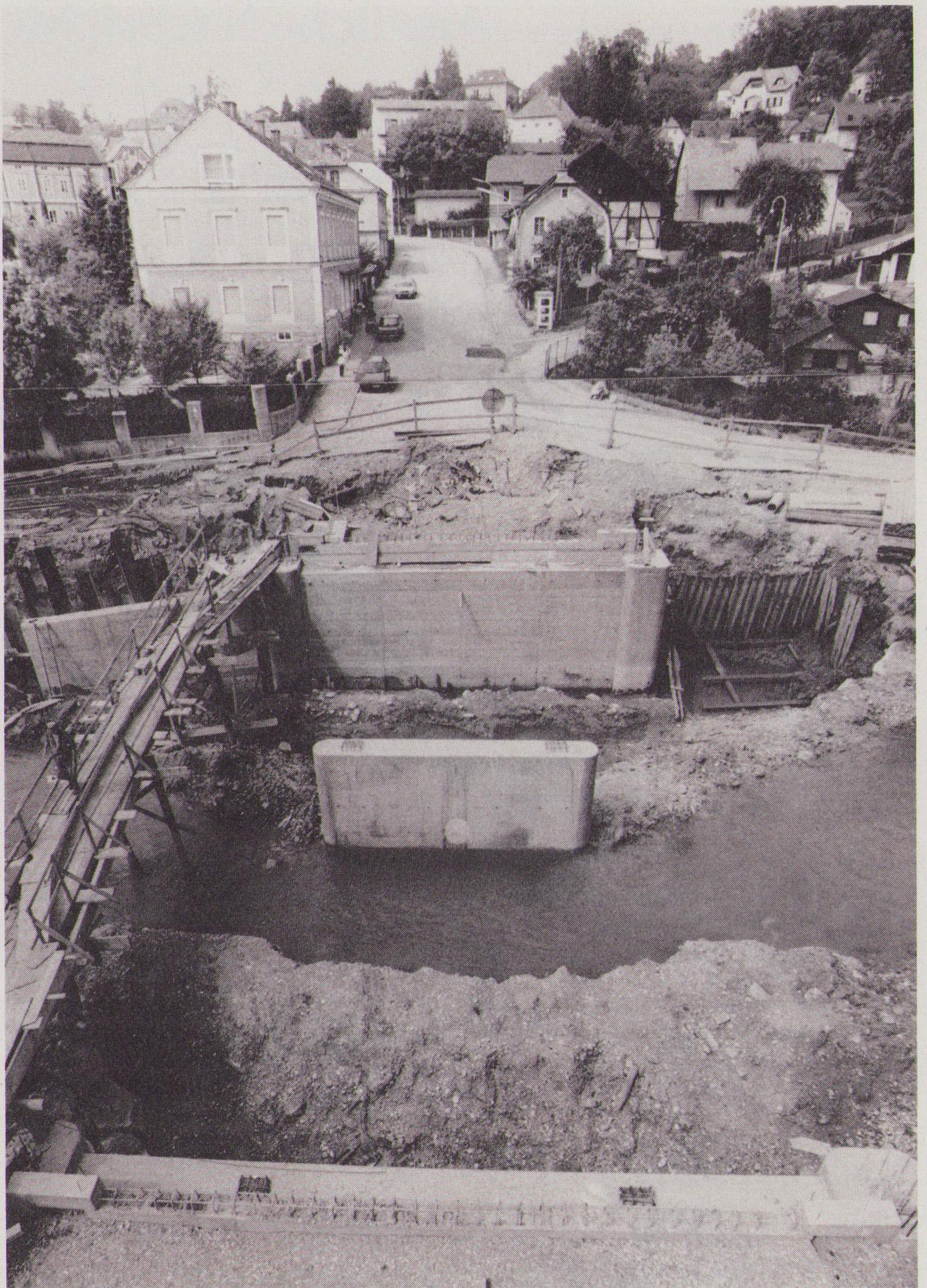
Zu den Bildern; linke Seite: Oben der Mittelpfeiler der neuen Brücke, unten die hangseitige Ufermauer. Sie sichert die Fabrikstraße und die darüber liegenden Grundstücke. – Blick von der Vogelperspektive aus auf die Brückenbaustelle mit Widerlagern und Mittelpfeiler. Der Bausteg, rechts im Bild, trägt die Telefonkabel.
