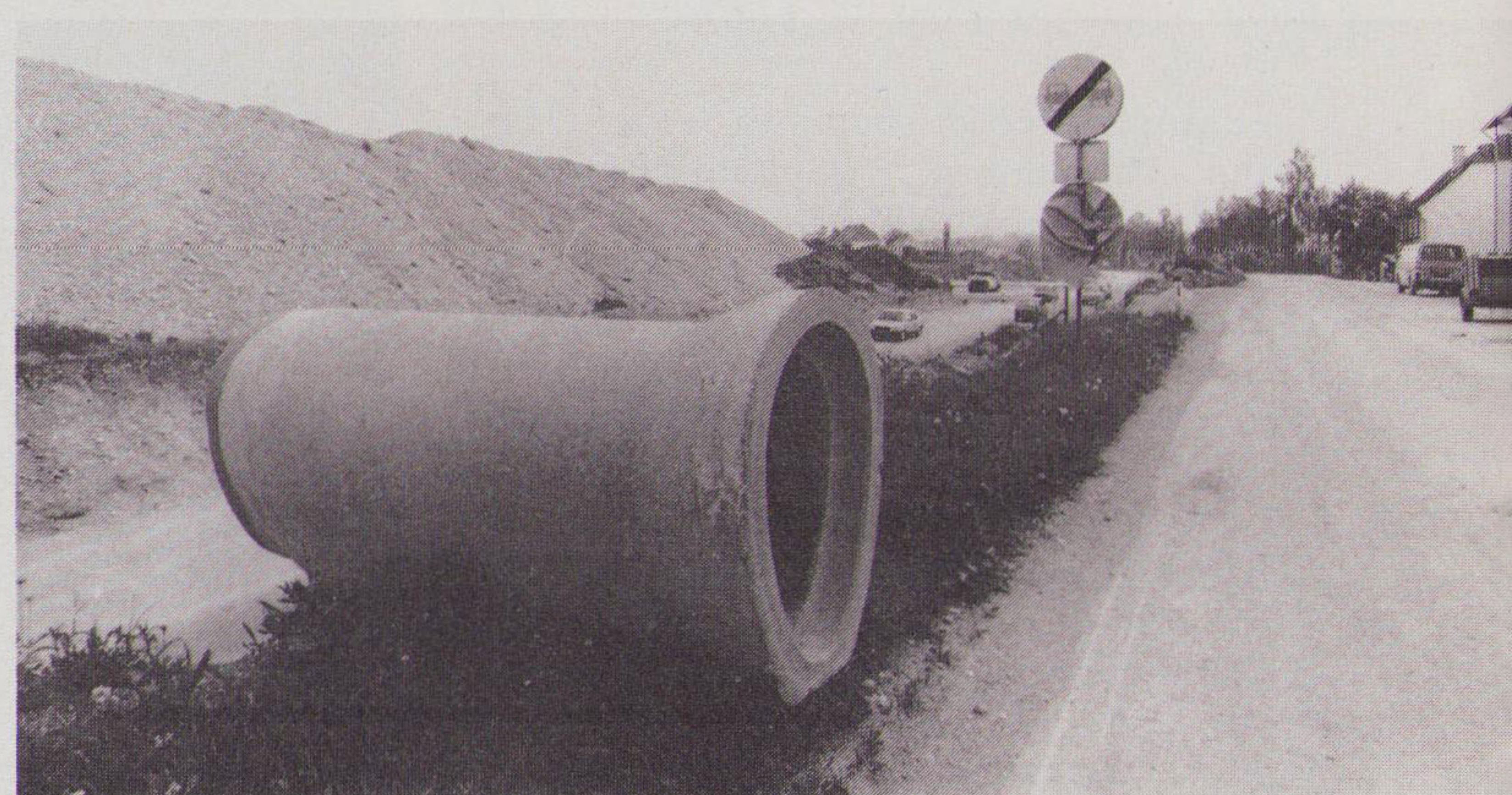
Oben: Unter die alte Trasse der Voralpen-Bundesstraße (rechts im Bild) wurde der neue Hauptsammler verlegt. In diesem Bereich mündet die Druckleitung von der Pumpstation bei der Kruglbrücke ein.
