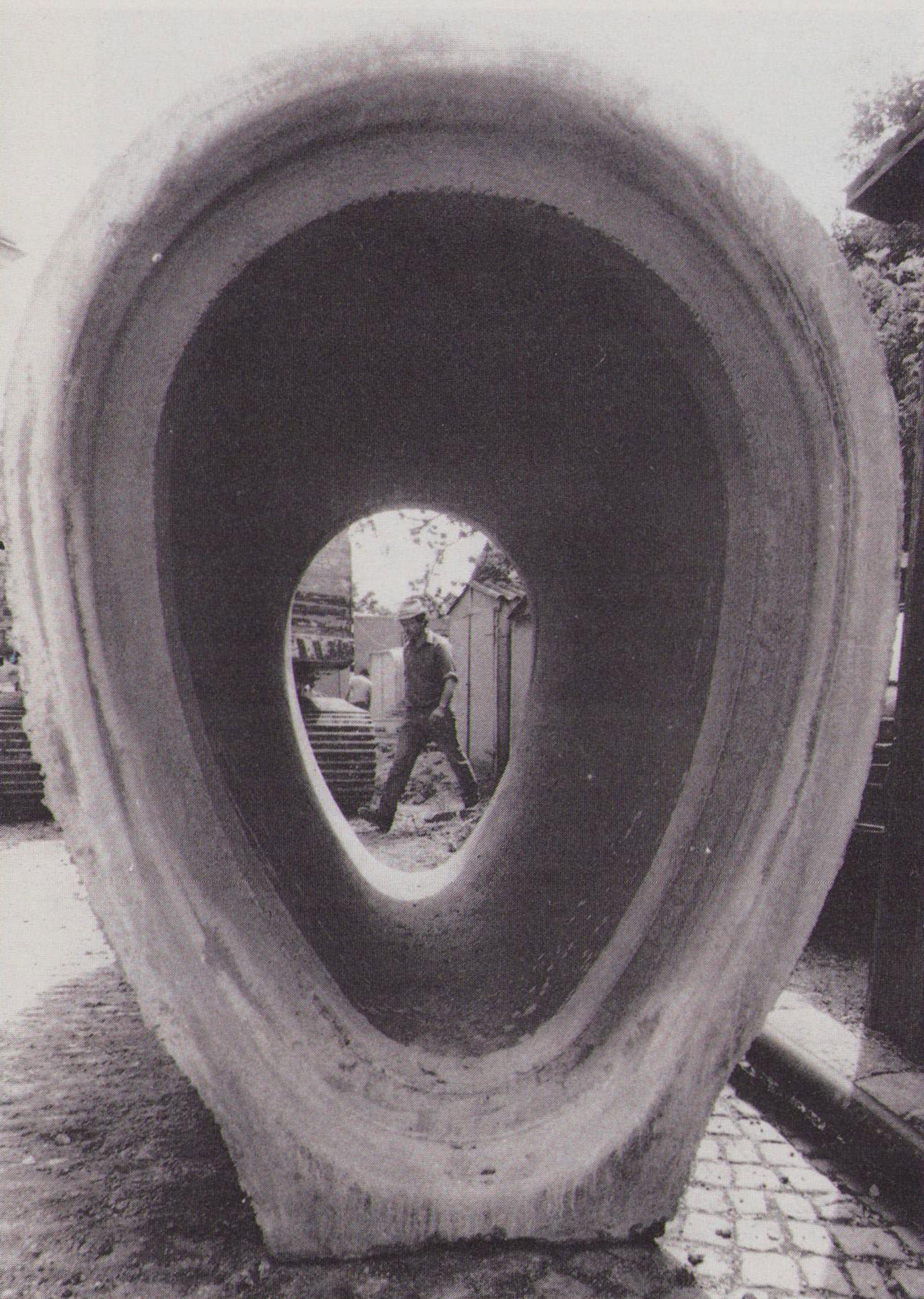
Links des Wehrgrabengerinnes werden in der Fabrikstraße Fertigteilebetonrohre „Ei-100/150 cm“ eingebracht.
