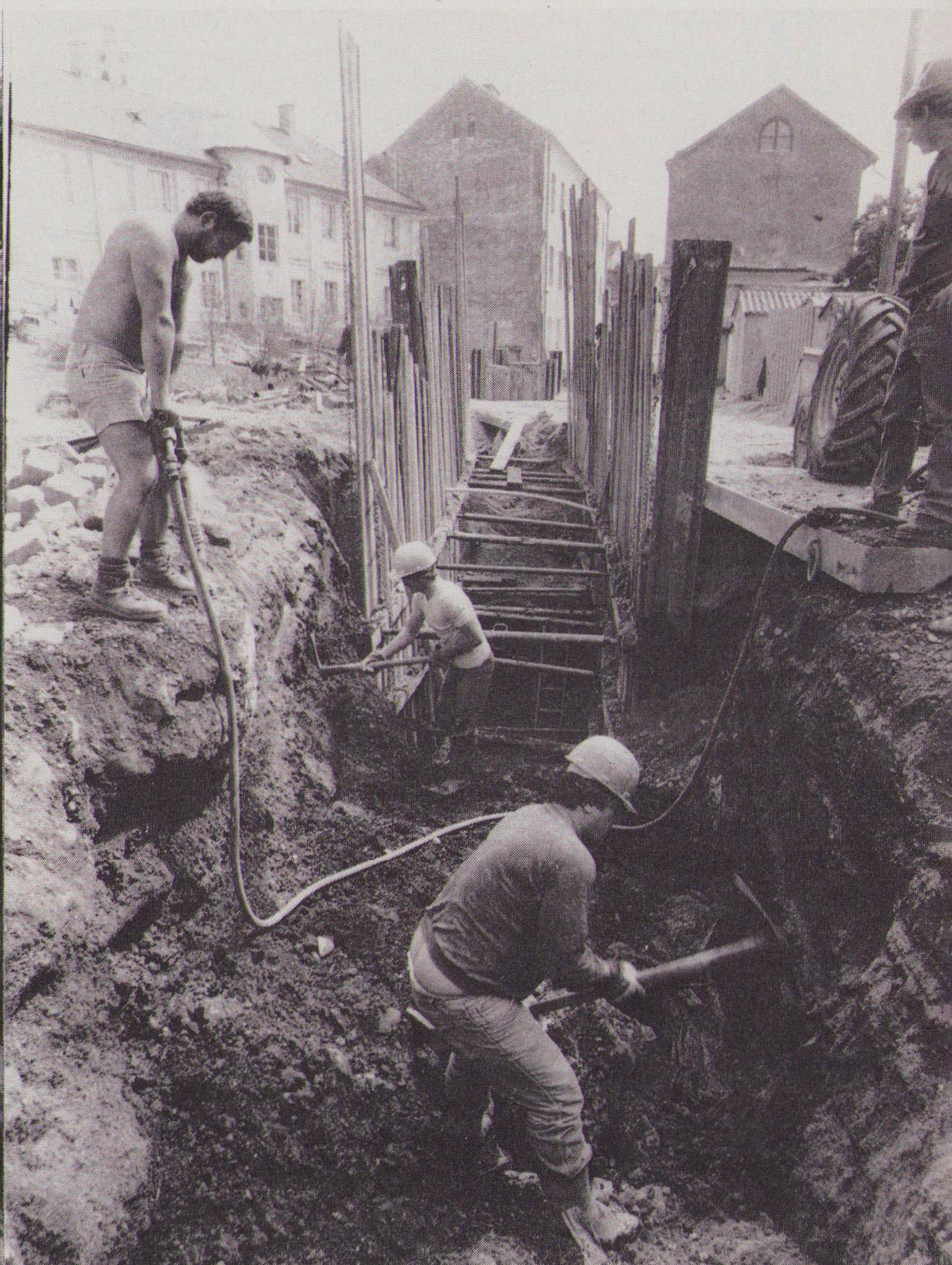
Aushub der Kanalkünette im Bereich Fabrikstraße beim Direktionsberg.
