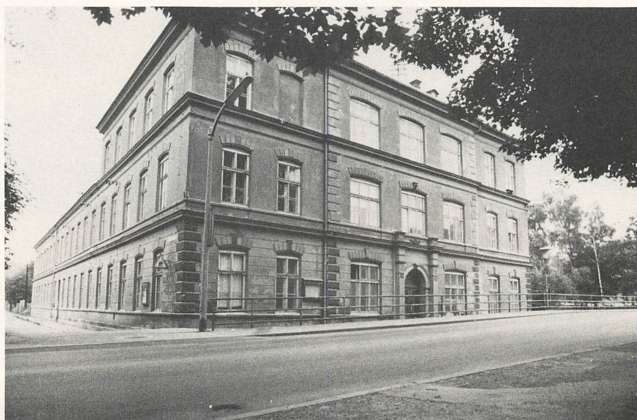
Das alte Gebäude der ehemaligen Handelsschule und Handelsakademie wird abgetragen.
