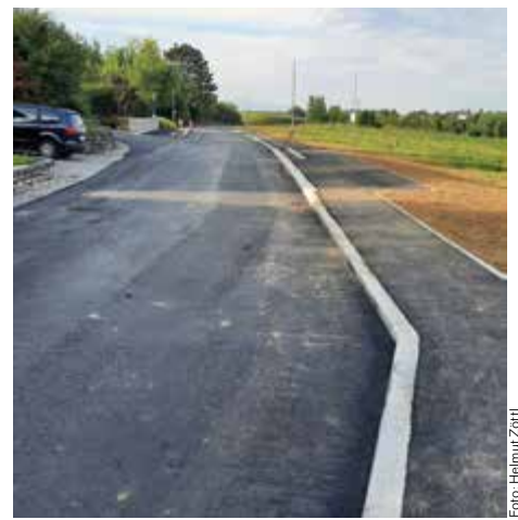
Die Feldstraße (zwischen Wolfen- und Steiner Straße) ist komplett saniert worden ist – inklusive Neuerrichtung eines Gehsteiges.
