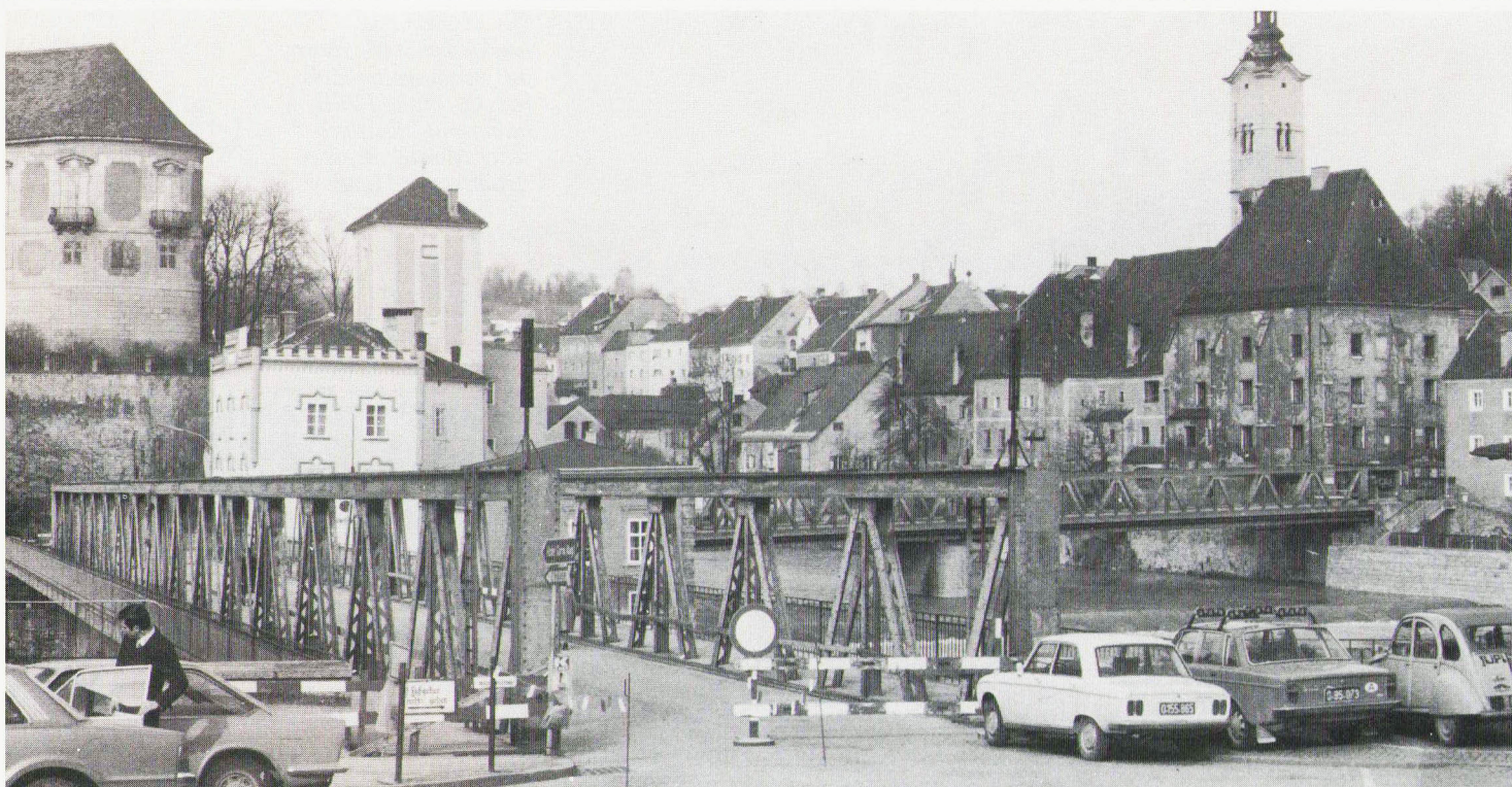
Nahezu ein Jahrhundert prägten diese Stahlkonstruktionen das Stadtbild in Zwischenbrücken.
